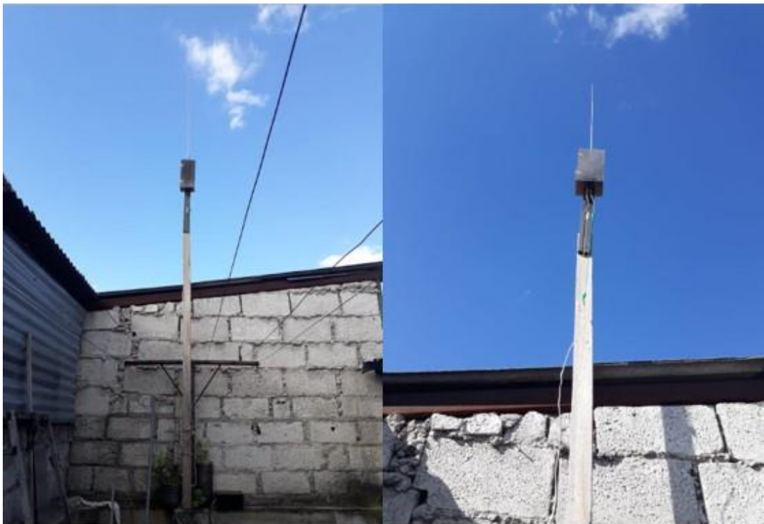
Figura 51. Colocación de la antena y sistema RF
