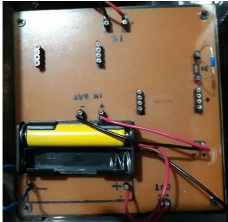
Figura 135. Batería colocada en el módulo de almacenamiento
