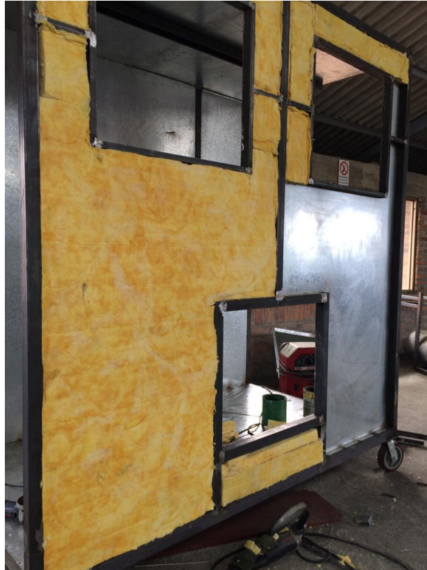
Figura 96 Aplicación pared aislante.
