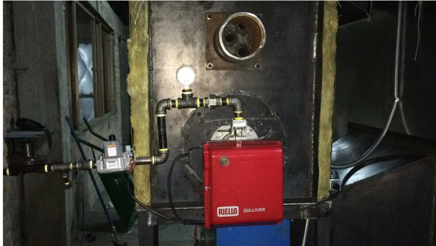
Figura 104 Sistema combustible GLP Acoplado.
