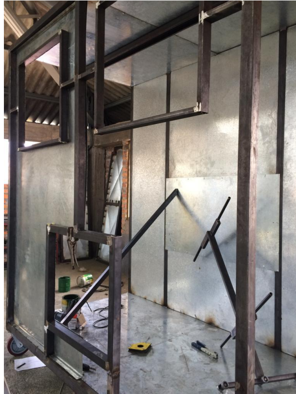
Figura 94 Estructura Cabina de Curado final.
