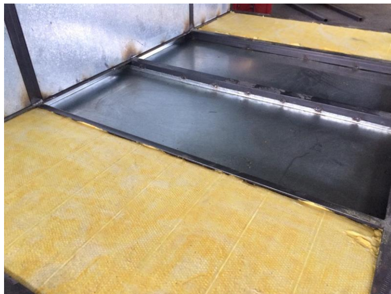
Figura 95 Aplicación pared aislante.
