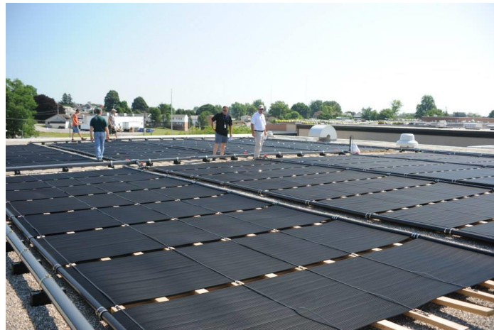
Figura 9. Colector de placa plana sin cubierta [57]
