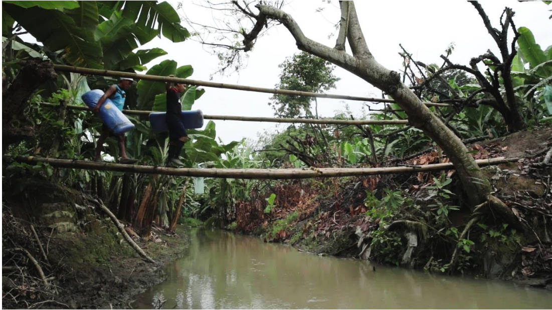
Fotografía 12. Sobre la zanja más grande de la plantación existe un puente construido por los mismos jornaleros. Fotografía: María Elissa Torres
