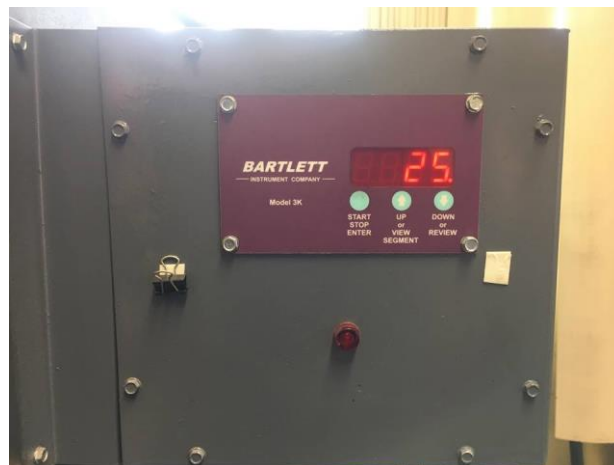
Figura 105 Controlador de temperatura del horno Fuente: Autores
