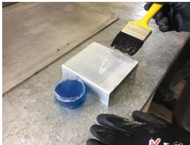
Figura 104 Aplicación de alcohol polivinílico sobre molde Fuente: Autores
