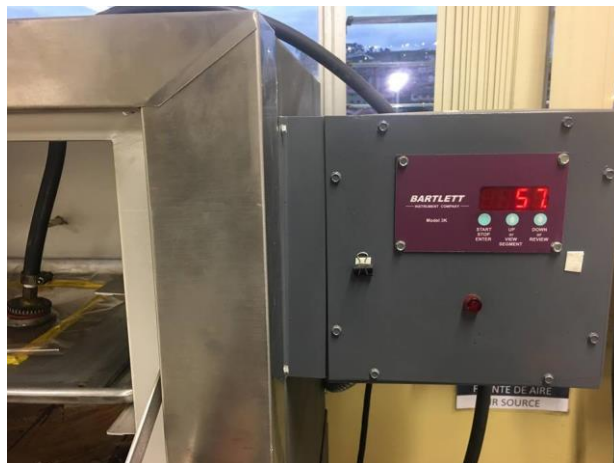
Figura 119 Temperatura final de enfriamiento Fuente: Autores
