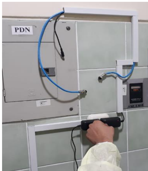
Figura 51. Instalación eléctrica del dispositivo.
