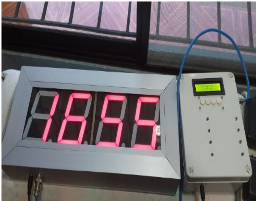
Figura 75. Pruebas de funcionamiento de pantalla led y unidad central.
