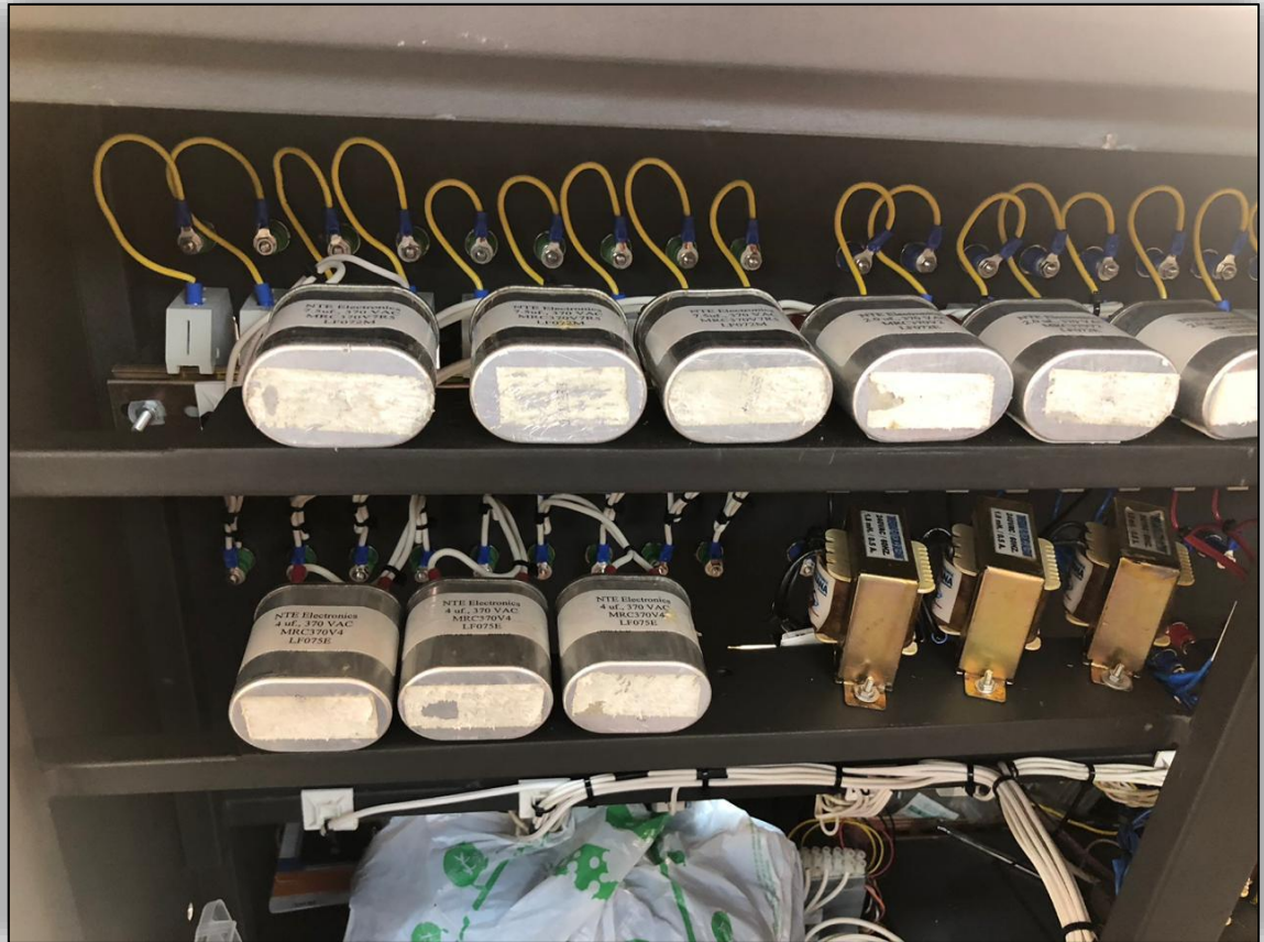
Figura 17. Conexionado de capacitores.
