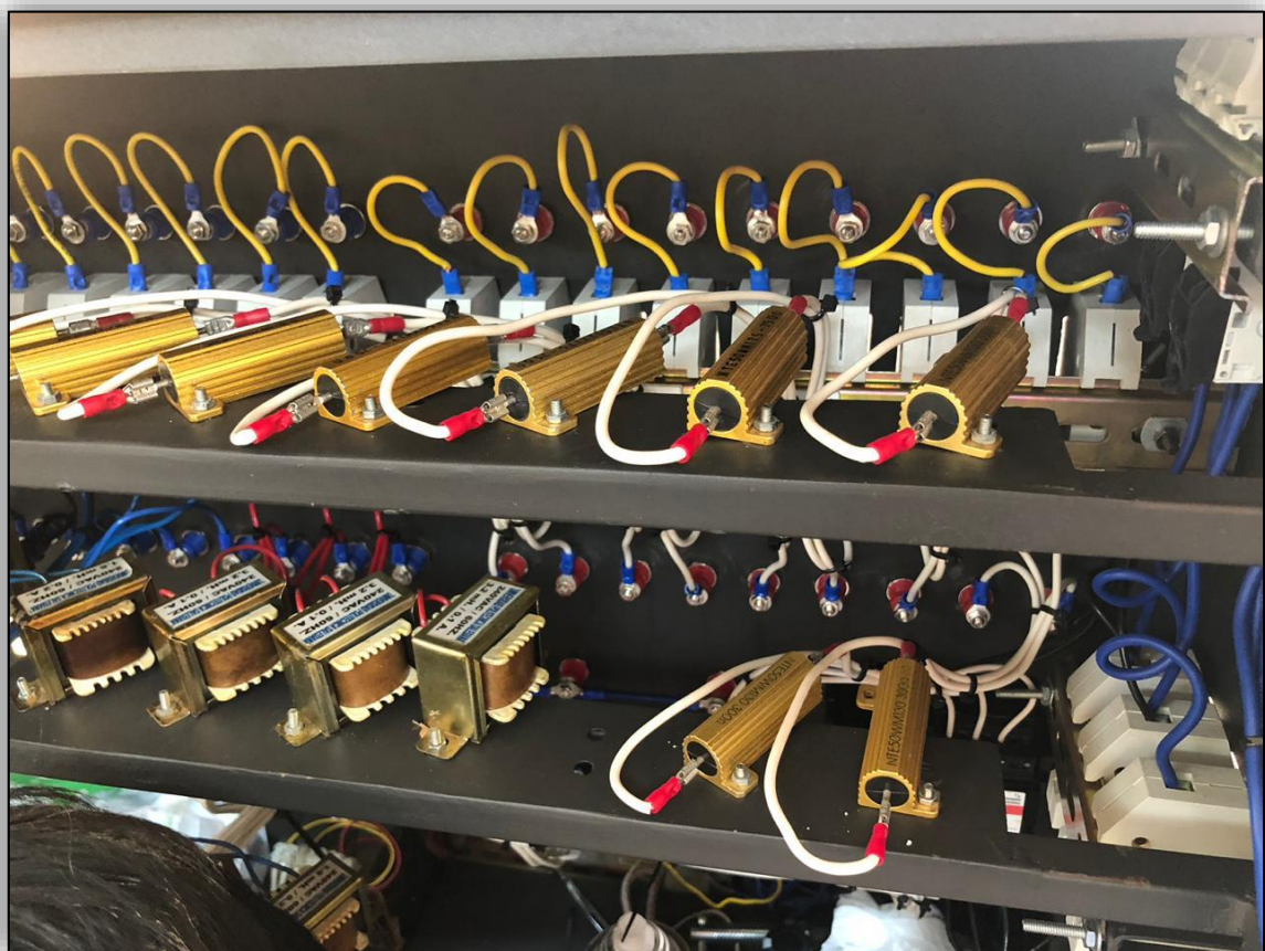
Figura 15. Conexión de resistencias fusibles e inductores.
