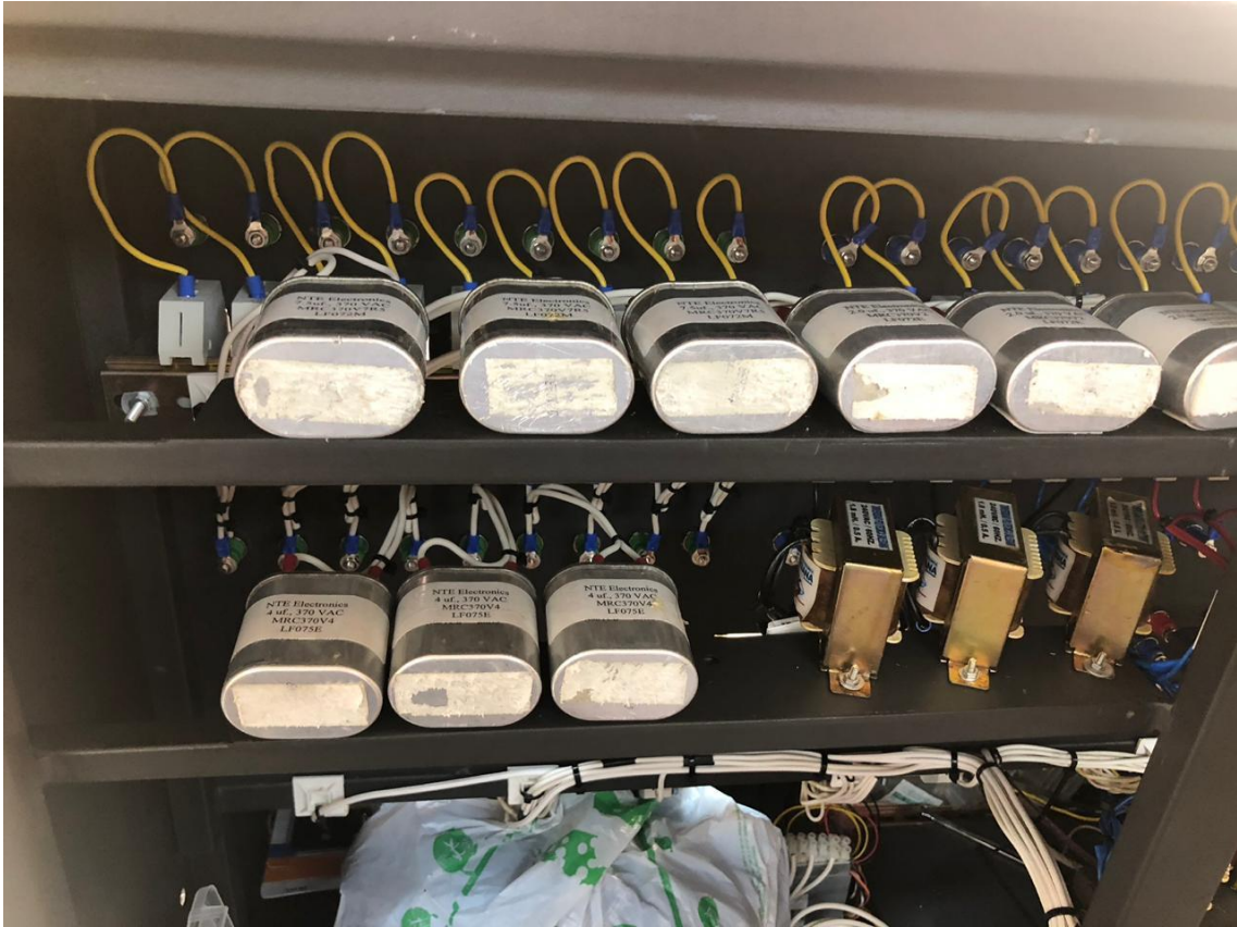
Figura 30. Verificación del cableado del módulo de circuitos de prácticas.
