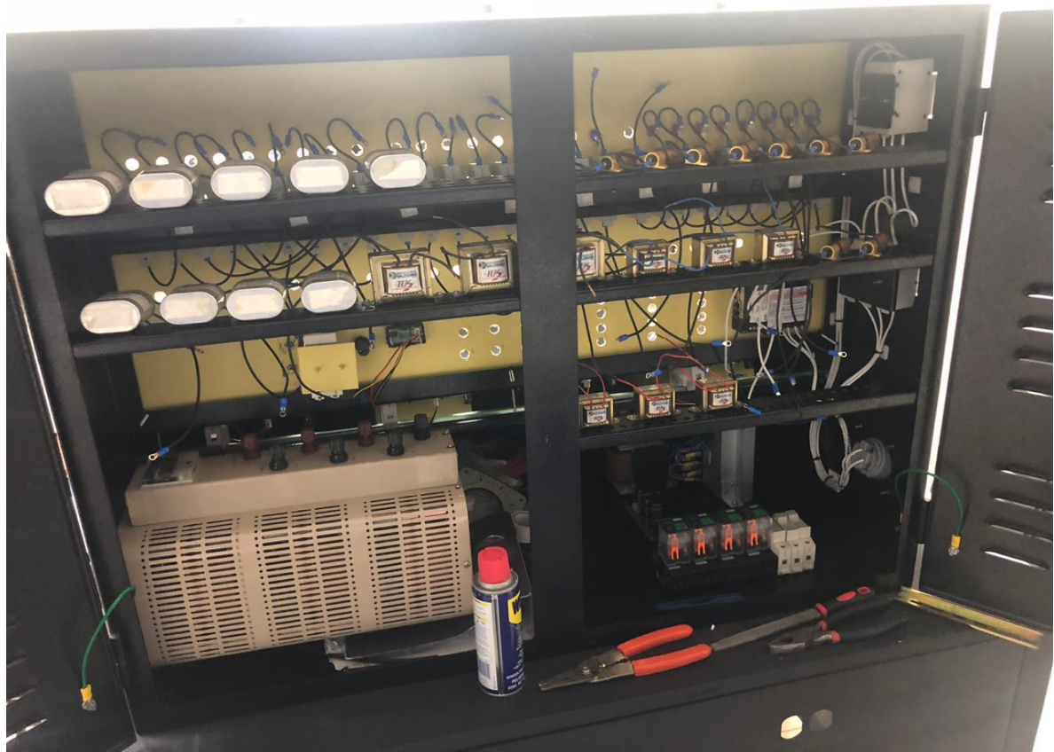
Figura 29. Adecuaciones del cableado del módulo de circuitos.
