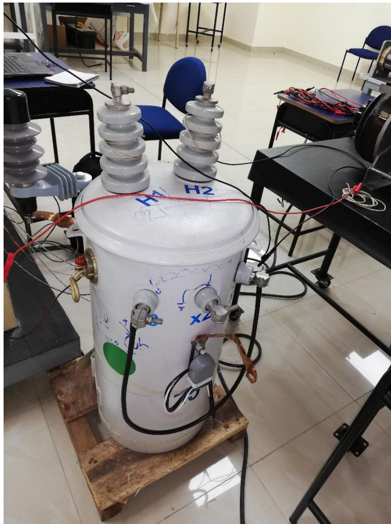
Figura 63. Transformador de distribución
