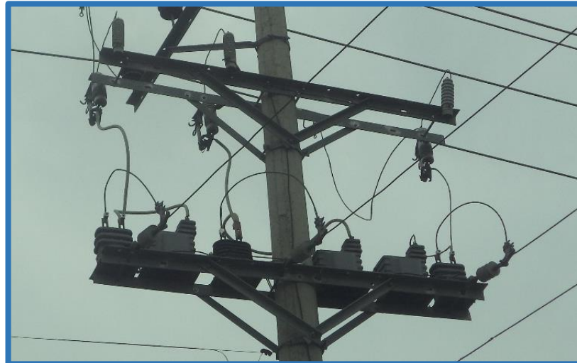
FIGURA 22: EQUIPOS DE MEDICIÓN CTS Y PTS.
