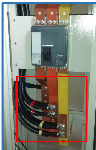
FIGURA 87: CONEXIÓN DE ACOMETIDA CON TERMINALES DE COMPRESIÓN.
