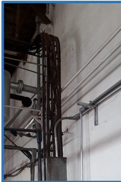
FIGURA 35: BANDEJA PORTACABLE.
