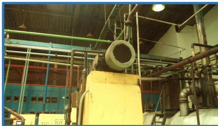
FIGURA 36: BANDEJA PORTA CABLES Y TUBERÍAS
