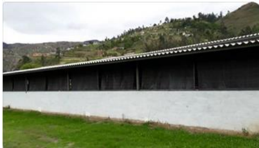
Foto 2. Colocación de cortinas.
