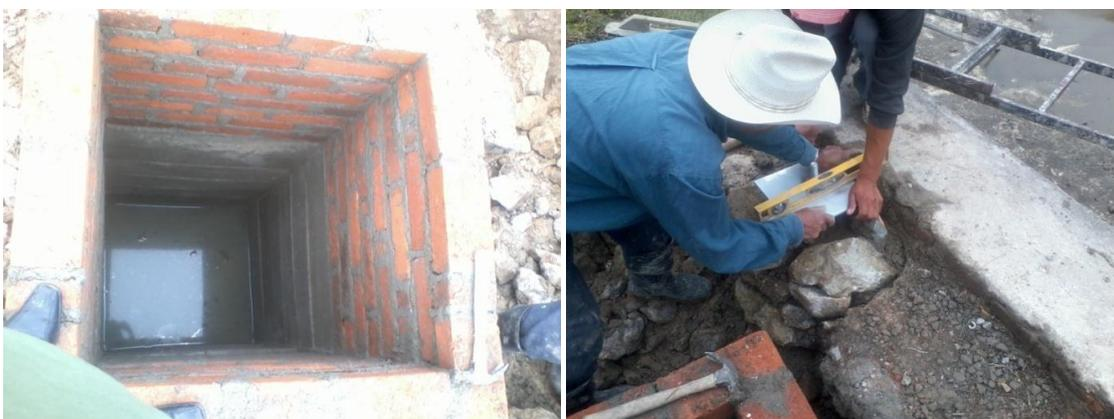
Fotografía 9 y Fotografía 10. Construcción del pozo de abastecimiento y zapatas
