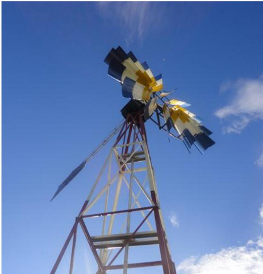
Fotografa 17 Aerobomba con eje de bombeo instalado
