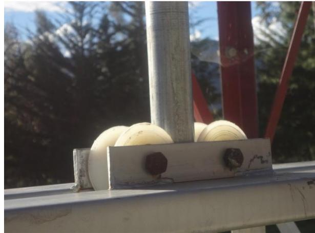
Fotografía 14 Sujeción actual de diagonales con pernos. Fotografía 15 Orientación de la tubería de bombeo con ruedas guías
