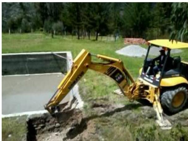
Fotografía 7 Perforado de suelo con la ayuda de una retroexcavadora
