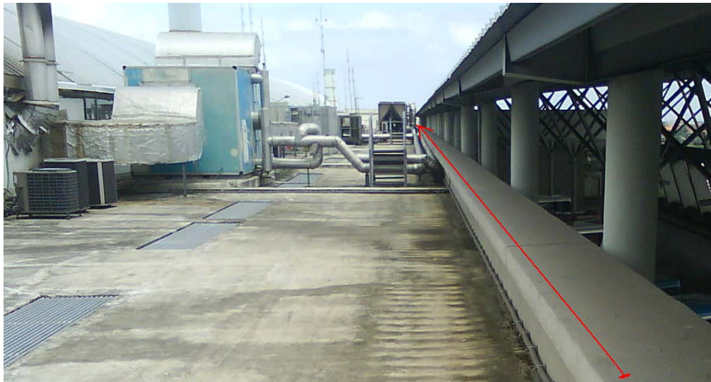
Figura 4.7 Trayecto del cable de red
