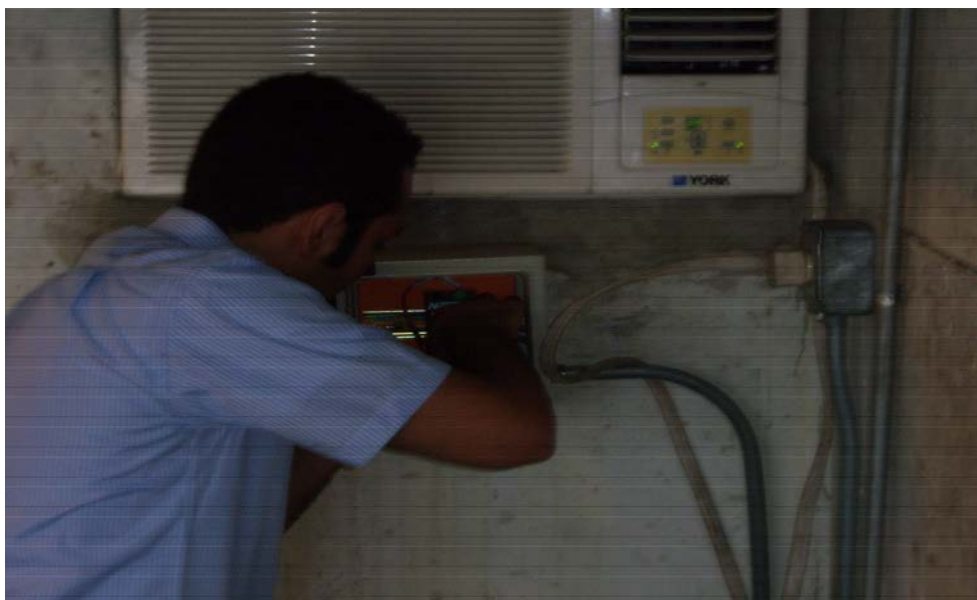
Figura 4.22. Instalación de Swich para comunicación
