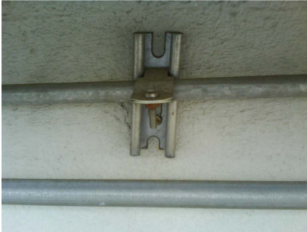
Figura 4.9 Tubería instalada
