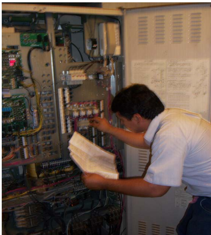
Figura 4.14. Revisando conexión de relays instalados Fuente: Autores 2011
