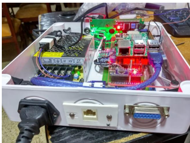
Figura 26. Vista trasera del sistema de monitoreo.
