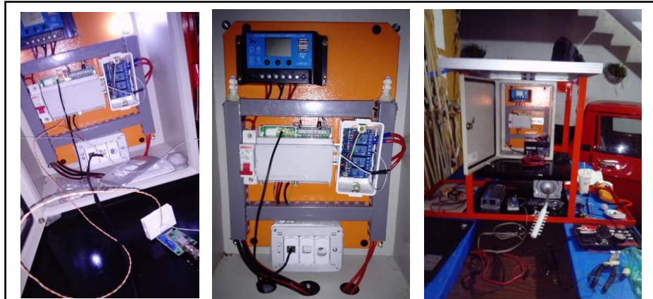
Fig. 69 Pruebas de funcionamiento de los sensores y el actuador por medio de SMS [Autor]
