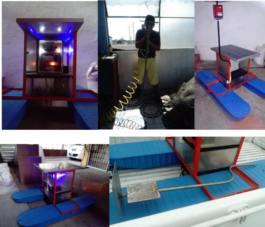
Fig. 80 Instalación de las paredes protectora y de la varilla con sus luces [Autor]
