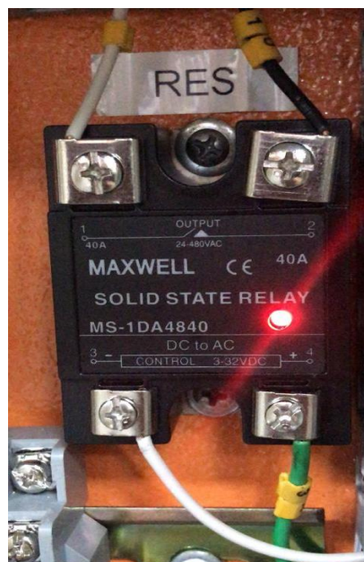
Figura 43: Relevador de Estado Sólido instalado en la planta
