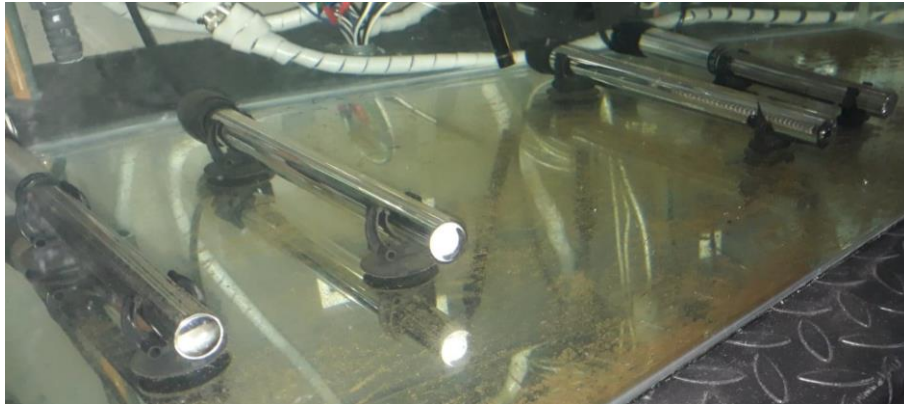
Figura 47: Resistencias instaladas en la planta
