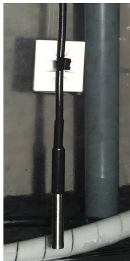
Figura 30: Sensor de Temperatura instalado en la planta
