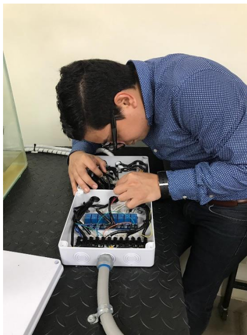
Figura 41: Instalación de Módulo XBEE en la planta
