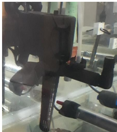
Figura 48: Bombas de oxígeno utilizada en la planta
