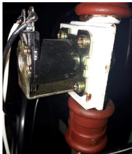
Figura 46: Electroválvula instalada en el sistema de tuberías de la planta
