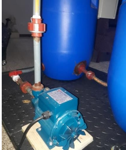
Figura 45: Bombas de agua utilizada en la planta
