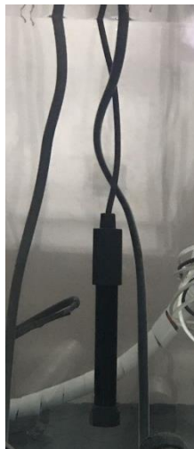
Figura 36: Sensor de oxígeno instalado en la planta
