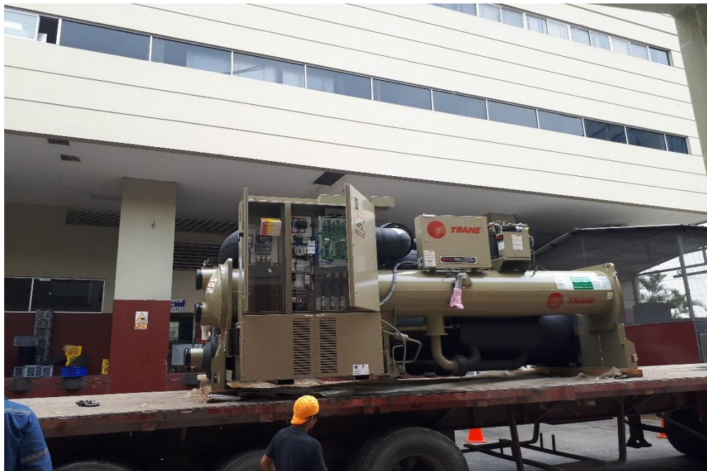
Figura 83 Desfundando nuevo chiller centrífugo
