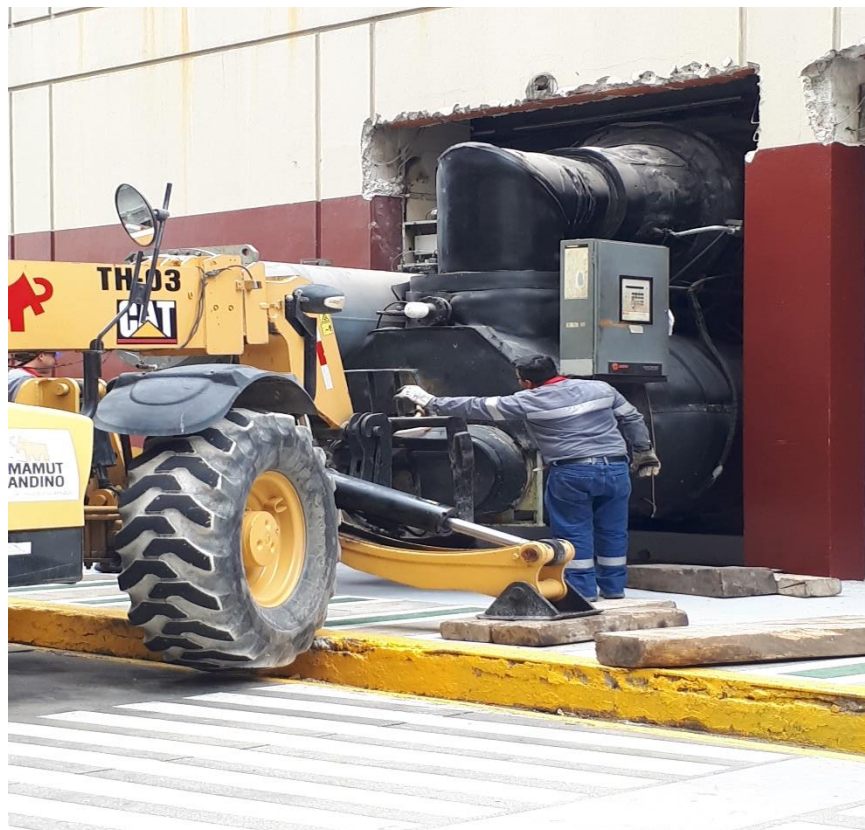
Figura 77 Proceso de desmontaje del chiller
