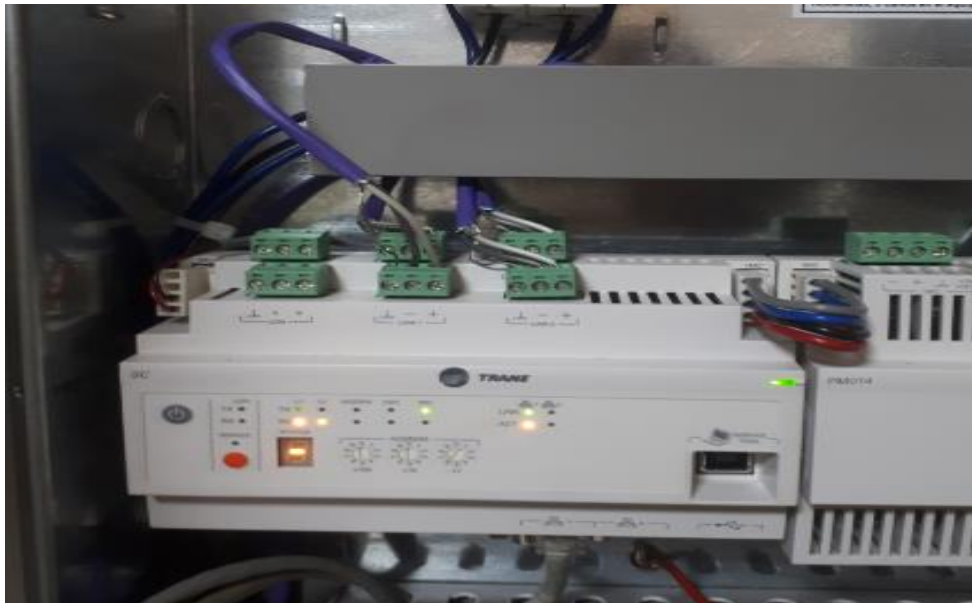
Figura 16 Cable blindado de bajo voltaje
