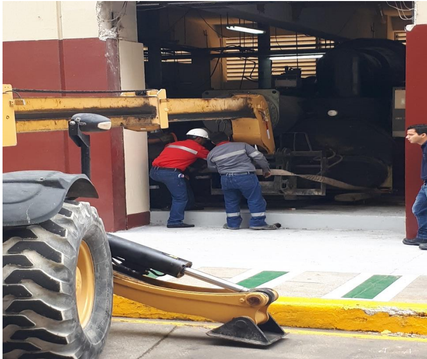
Figura 76 Preparación para el desmontaje del chiller
