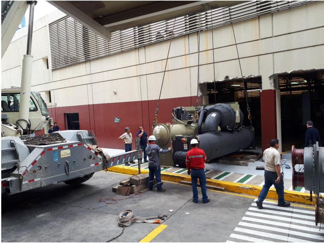
Figura 84 Colocación del nuevo chiller en el cuarto de bomba
