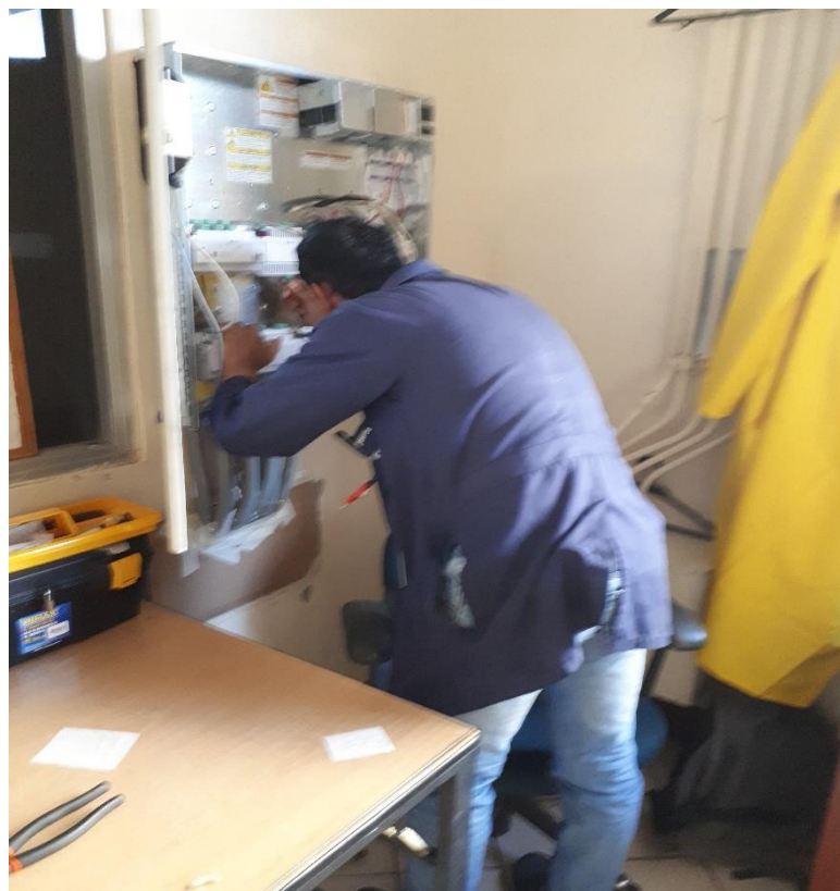
Figura 36 Ajuste de los terminales en el módulo UC600
