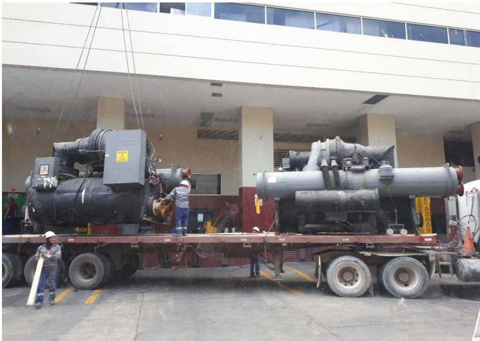
Figura 81 Chillers fue trepado en un tráiler para ser trasladado a bodega
