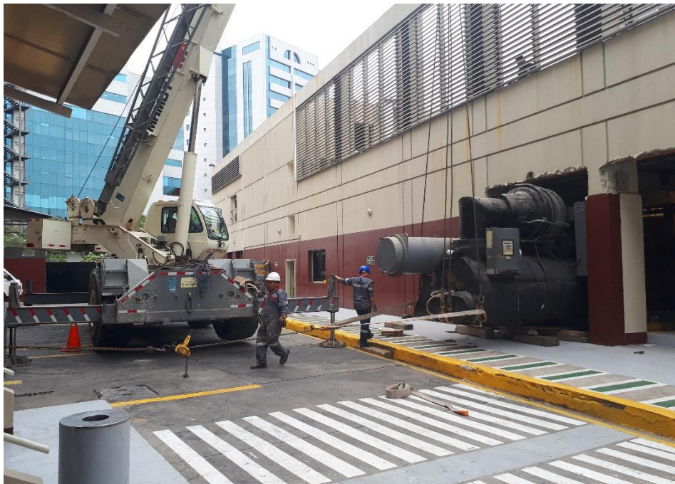
Figura 78 Colocación de los ganchos para ser removido el chiller
