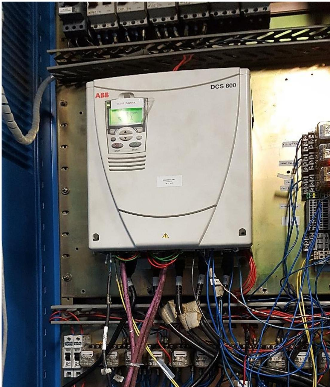
Figura 3.3 Montaje de DRIVE ABB DCS 800 para motor del rebobinador
