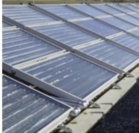
**Figura 19.** Colector parabólico compuesto [70].
