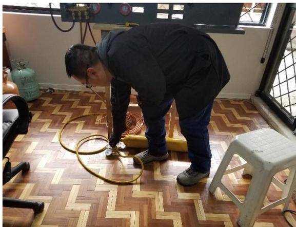
**Figura 51.** Inspección de fugas con  $N_2$ .
