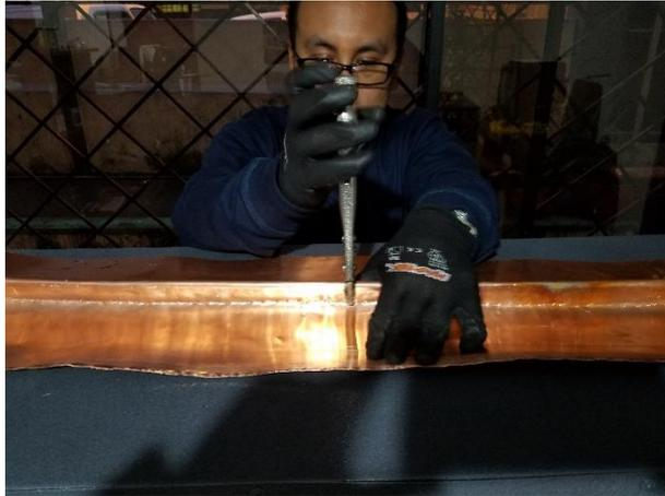
**Figura 46.** Acople de tubería en paneles del evaporador.
