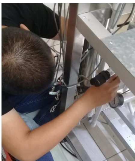
Figura 53. Instalación del sensor de flujo en la planta de agua.
