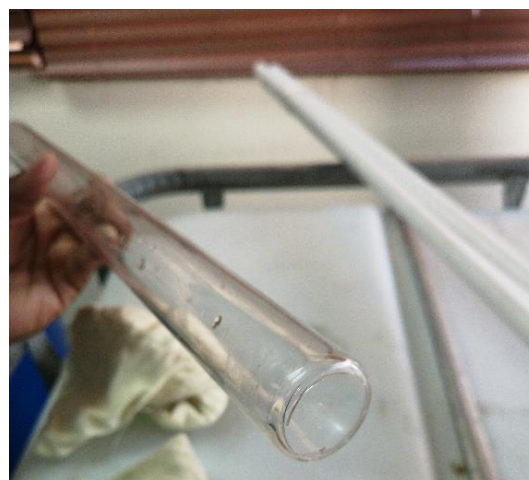
Figura 39. Limpieza de Luz Ultravioleta antes de la instalación.
