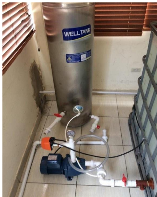
Figura 33. Instalación del sistema hidroneumático
