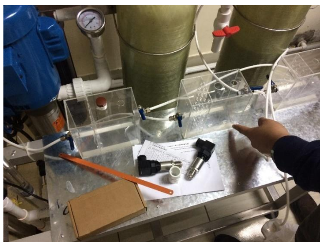
Figura 55. Instalación de los transductores de presión.
