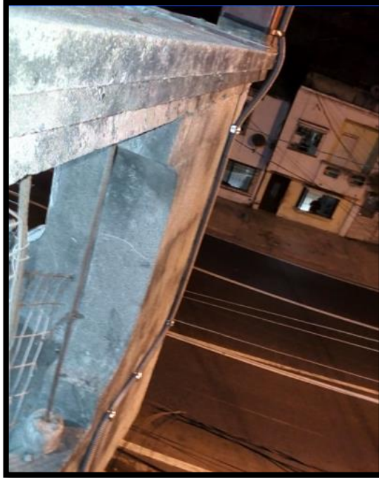
Figura 3.47: Ubicación tubería por donde descienden cableado desde planta alta
