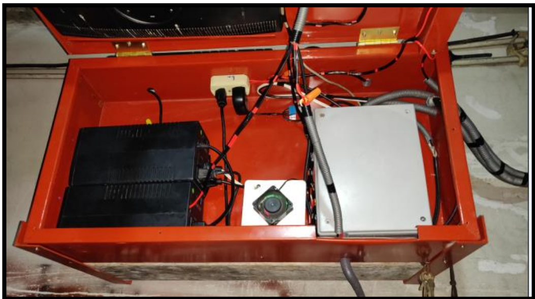
Figura 3.60: Vista de ubicación de equipos en el tablero
