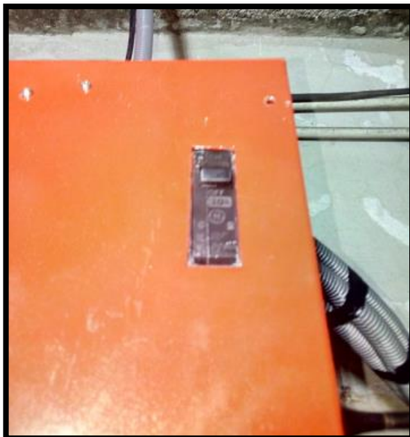
Figura 3.66: Alimentación eléctrica principal
