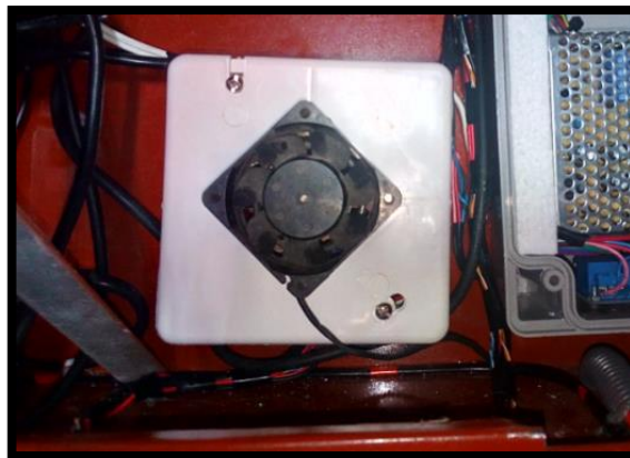
Figura 3.58: Caja dos finalizada
