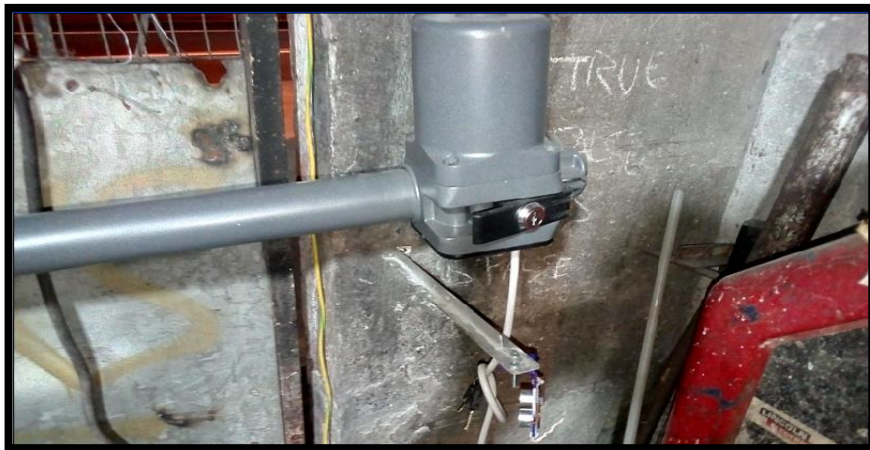
Figura 3.18: Instalación del sensor ultrasónico 2
