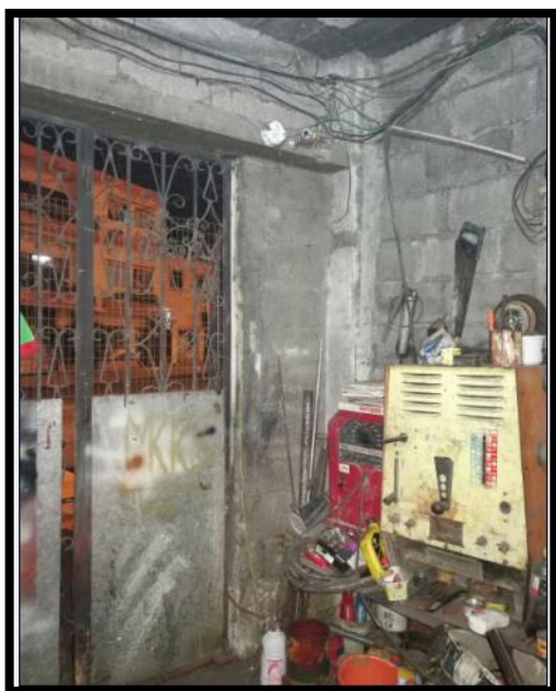
Figura 3.4: Puerta dos del portón
