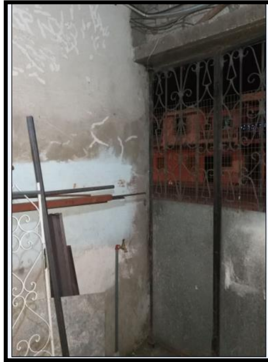
Figura 3.3: Puerta uno del portón
