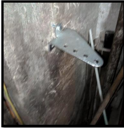
Figura 3.8: Sistema anclaje M2
