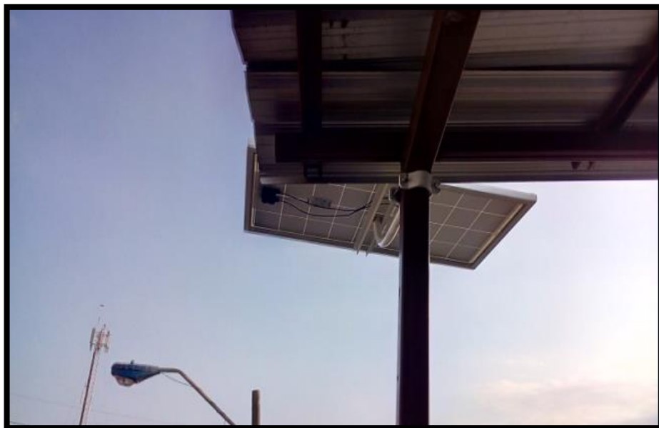
Figura 3.46: Ubicación Panel solar fotovoltaico visto desde planta alta
