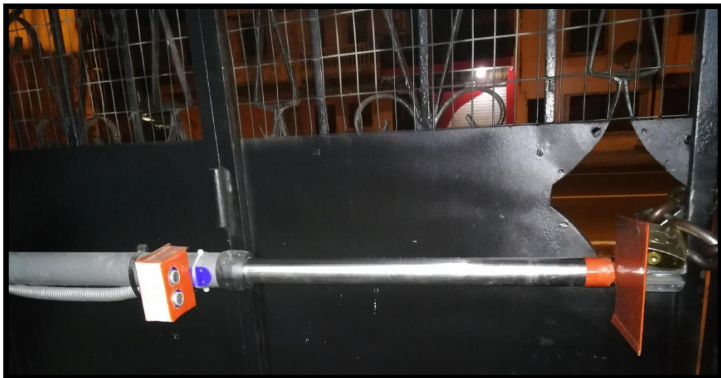
Figura 3.76: Ubicación motores con su cableado y sensor
