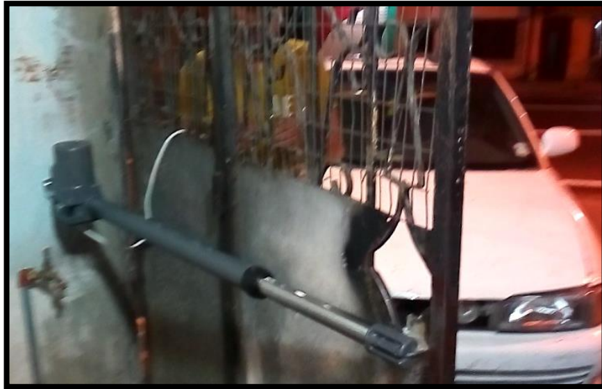
Figura 3.22: Prueba de accionamiento del motor
