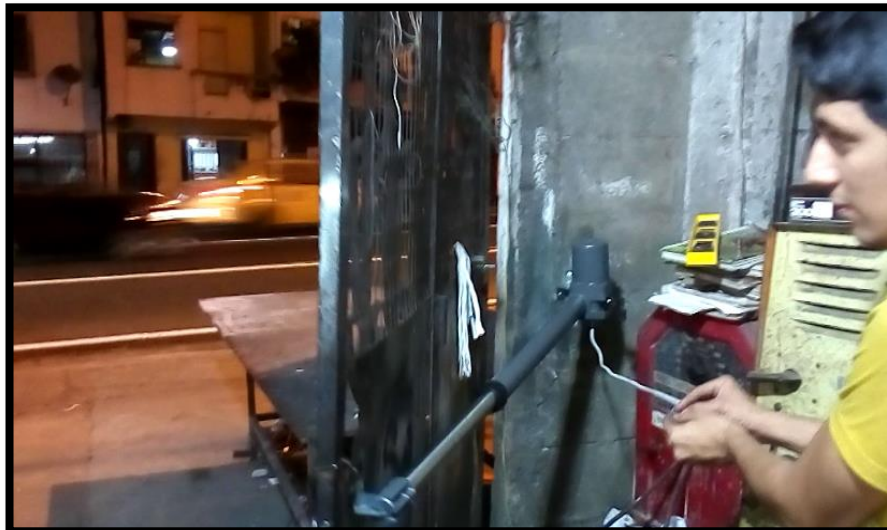
Figura 3.21: Prueba de accionamiento del motor
