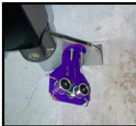
Figura 3.16: Instalación del sensor ultrasónico uno
