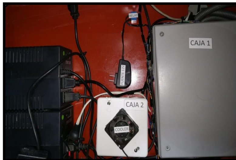
Figura 4.10: Interior del tablero Fotovoltaico
