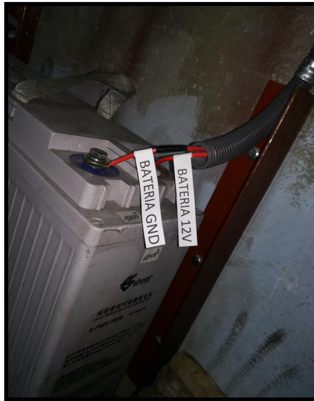
Figura 3.77: Ubicación cableado batería
