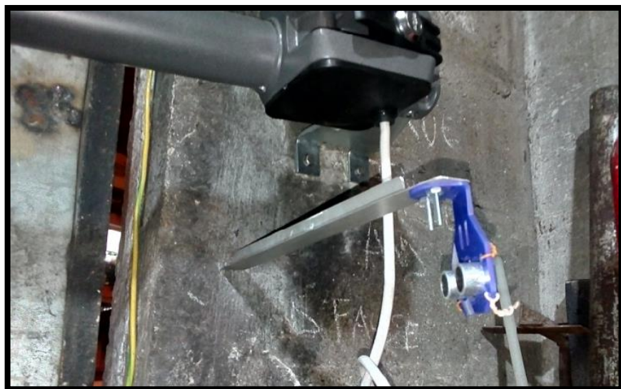
Figura 3.19: Instalación del sensor ultrasónico 2
