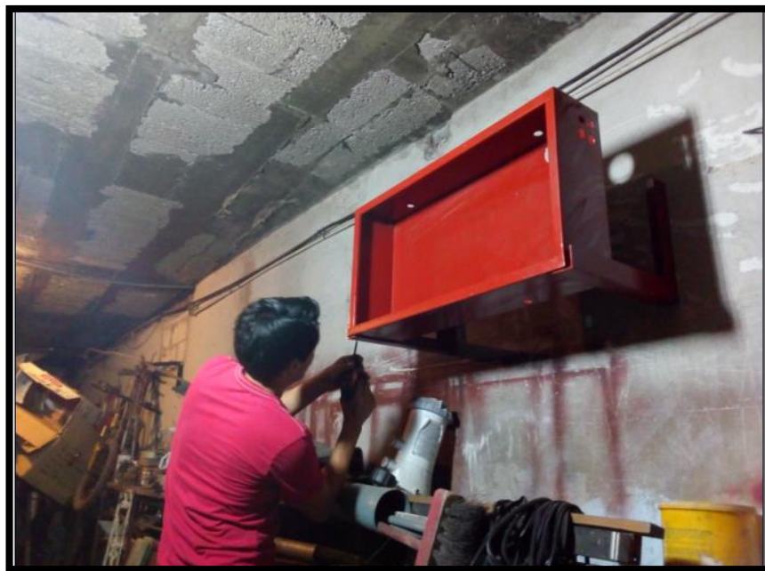
Figura 3.48: Ubicación tablero eléctrico en planta baja
