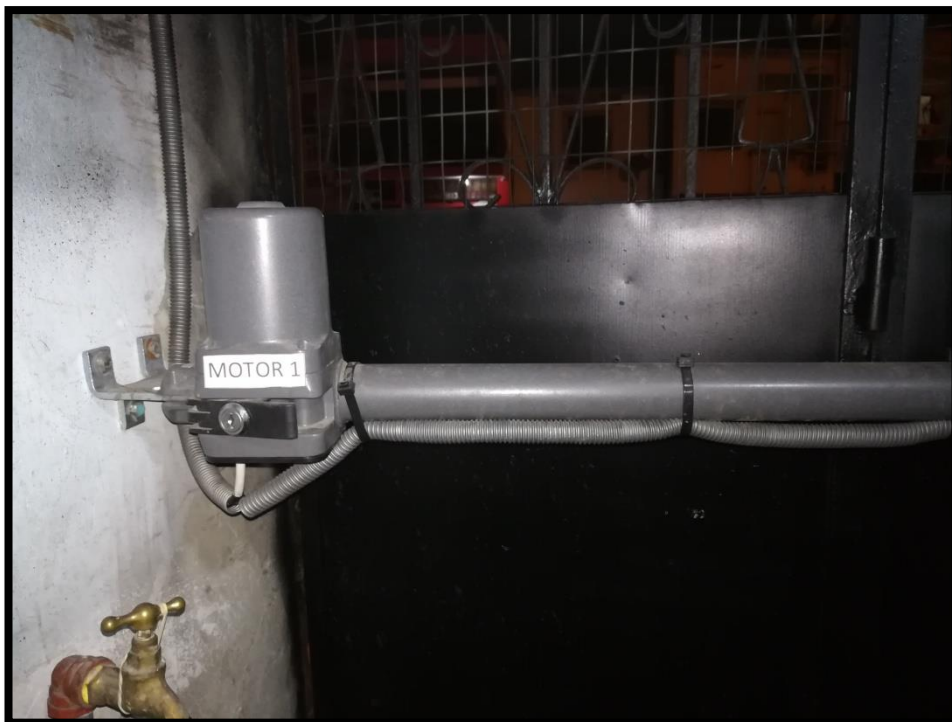
Figura 3.72: Ubicación motores con su cableado
