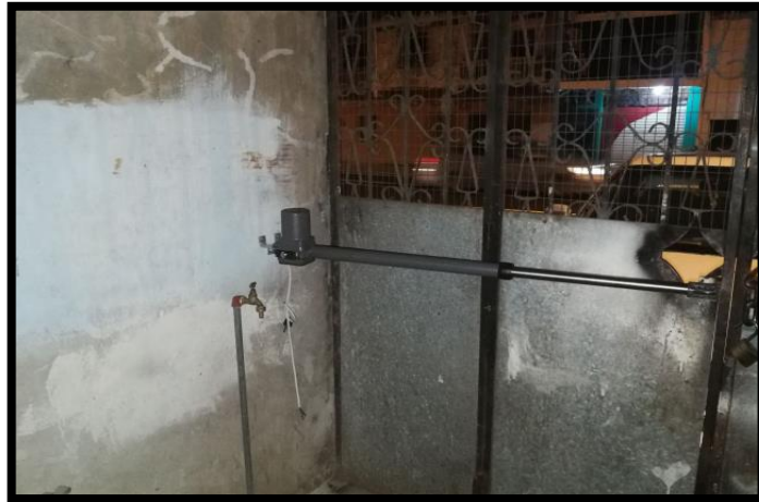
Figura 3.14: Vista del portón ya ubicado M1
