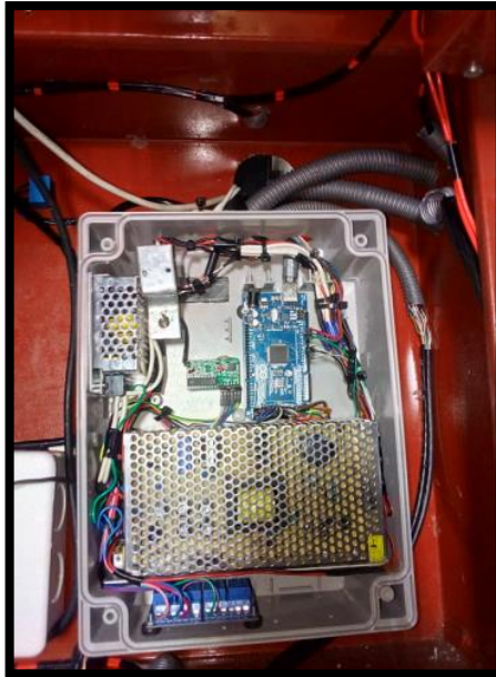
Figura 3.51: La caja 1 dentro del tablero
