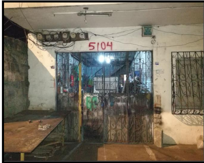
Figura 3.6: Vista exterior del portón
