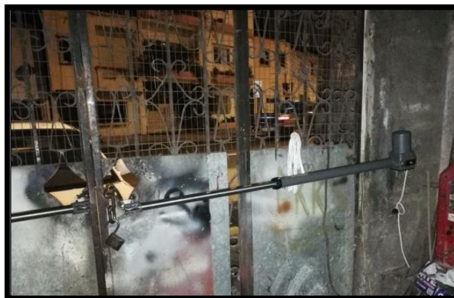
Figura 3.13: Vista del portón ya ubicado M2
