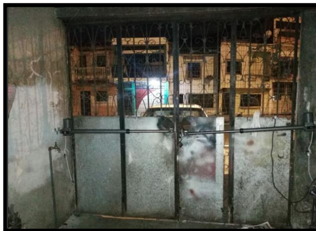
Figura 3.12: Vista del portón ya ubicado los motores
