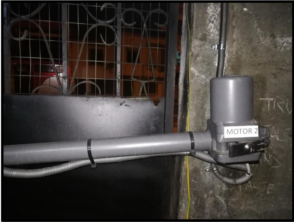
Figura 3.73: Ubicación motores con su cableado
