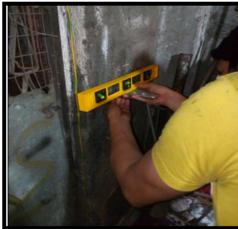
Figura 3.9: Calibración de la altura
