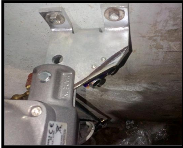
Figura 3.17: Instalación del sensor ultrasónico 1
