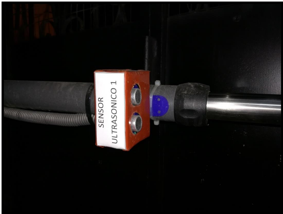
Figura 3.74: Ubicación motores con su cableado y sensor
