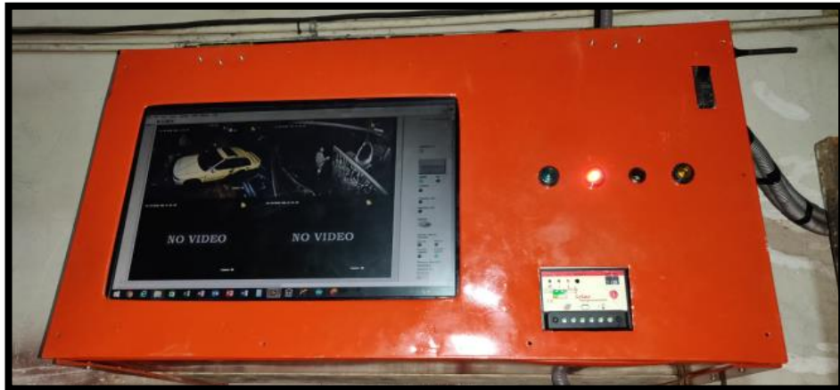
Figura 3.63: Vista externa del tablero
