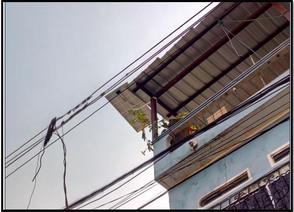
Figura 3.45: Ubicación Panel solar fotovoltaico visto desde planta baja
