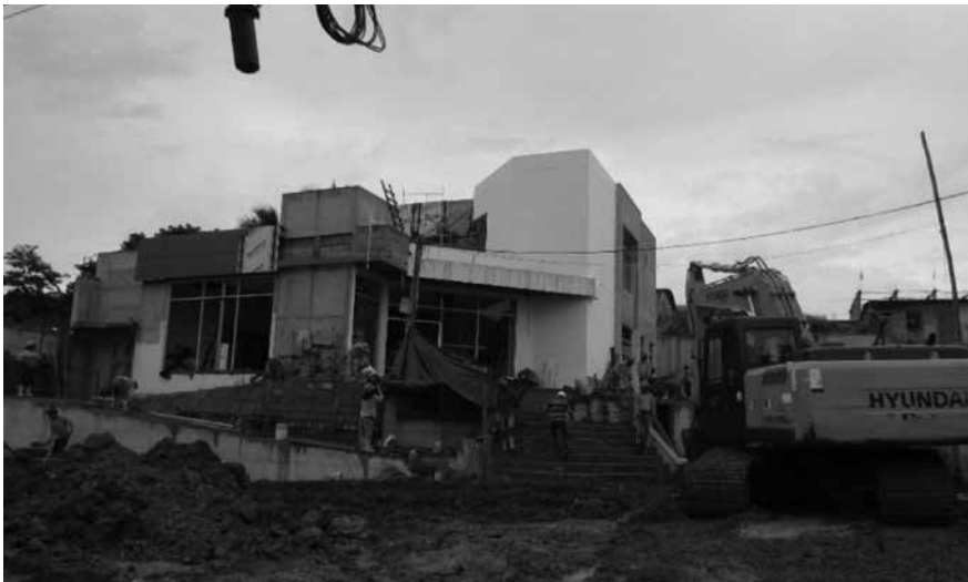
Foto 1. Nuevas construcciones en Pedernales
