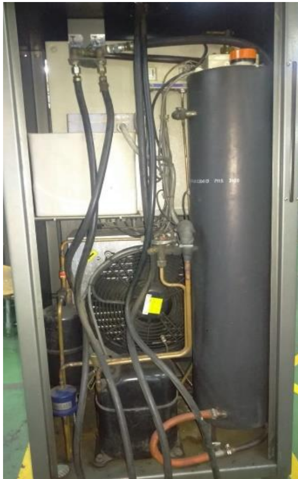
Figura 4.5 Armado de refrigeración
