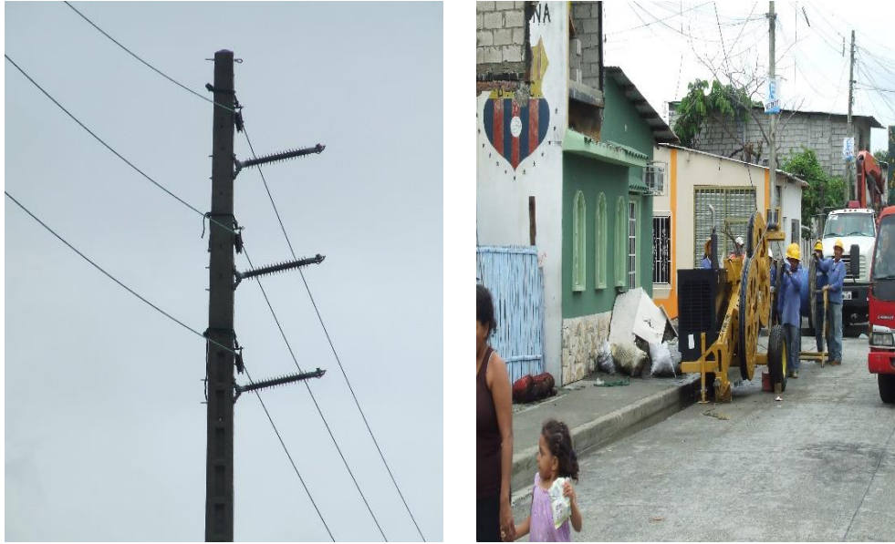
Figura 48: Tendido de conductor.
