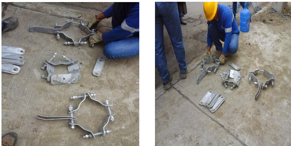
Figura 47: Pre armado de Herraje.
