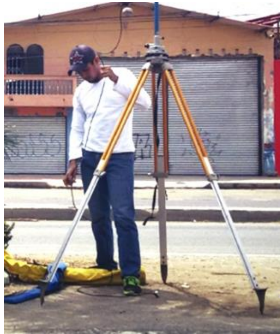
Figura 44: Replanteo de ruta.
