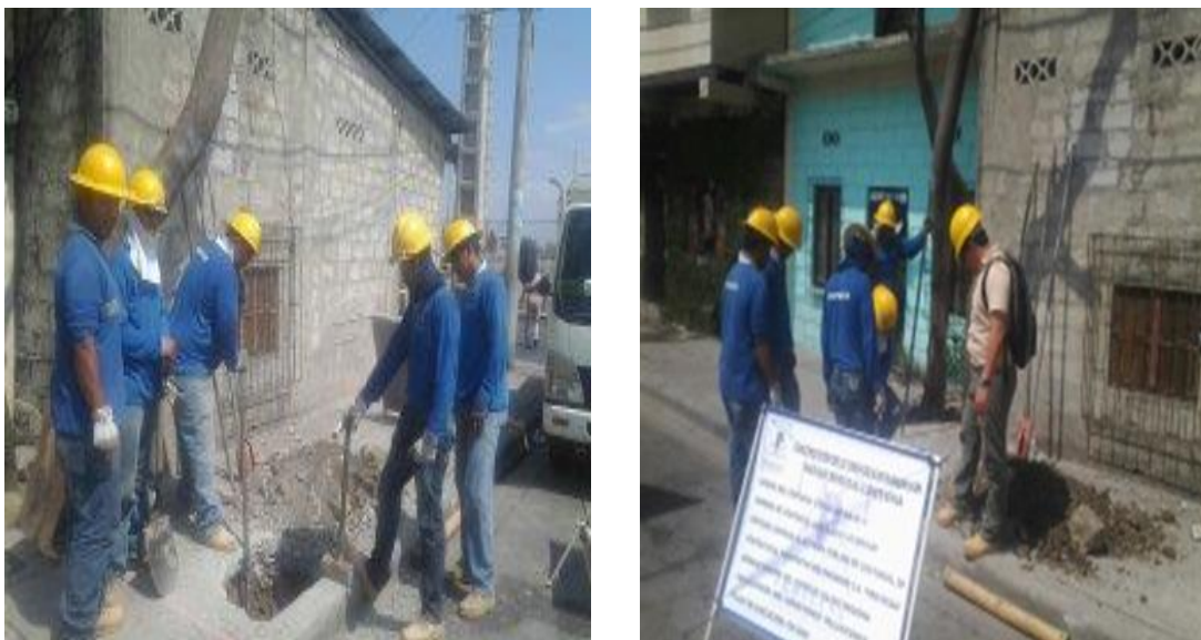
Figura 45: Hechura de Huecos - Poste.
