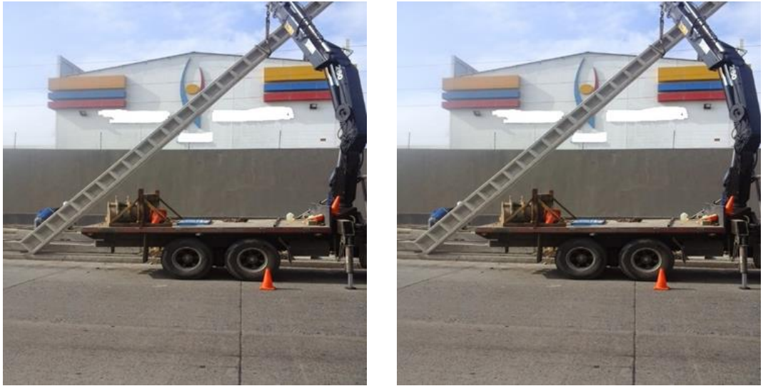
Figura 46: Izaje de Poste
