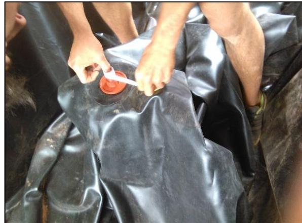
**Anexo 13.** Manguera para la conducción del biogás producido.
