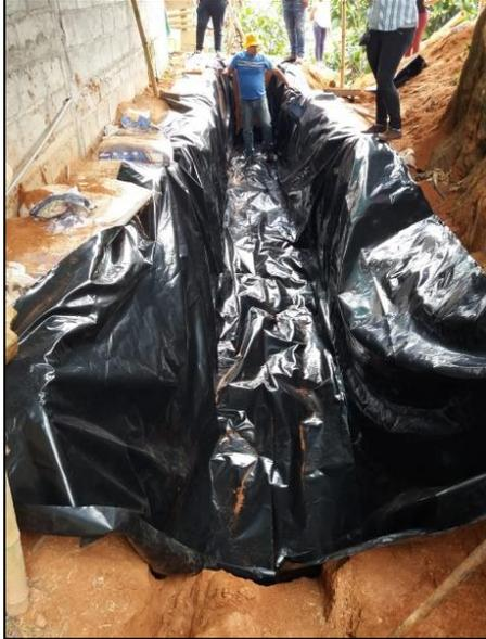
**Anexo 10.** Colocación del biodigestor en la zanja.
