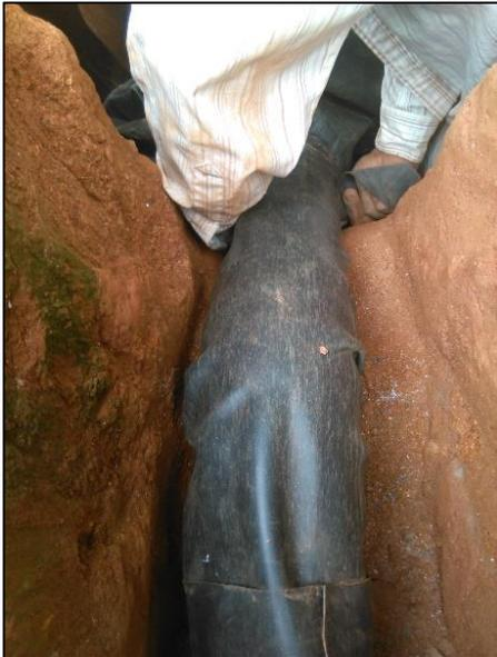
**Anexo 12.** Instalación de los accesorios para la salida del biogás.
