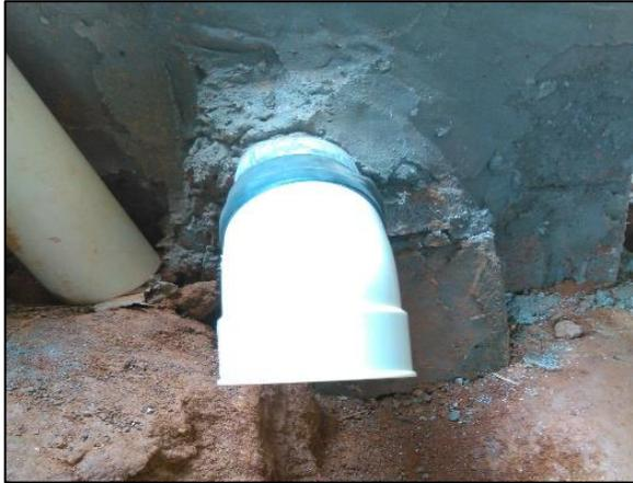
**Anexo 6.** Colocación de la sección de tubo para las mangas del biodigestor.
