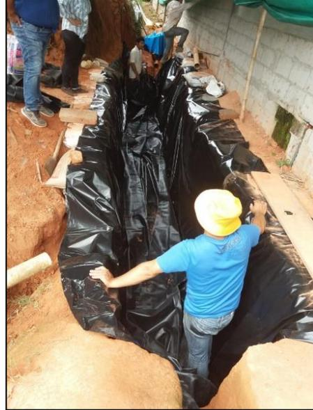
**Anexo 11.** Refuerzo de las mangas del biodigestor con ligas en los tubos de pozos de revisión.
