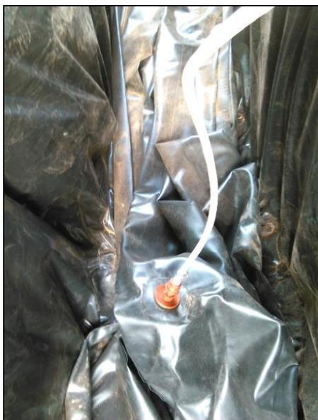
**Anexo 14.** Entrada de agua residual de los corrales porcinos, por medio del pozo de revisión, hacia el biodigestor.
