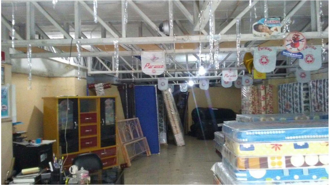
Anexo 3. Estado del local comercial antes de iniciar (Vista interior 3)
