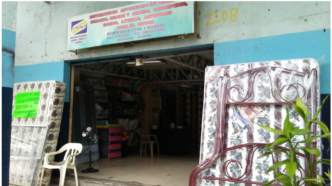
Anexo 1. Estado del local comercial antes de iniciar (Vista exterior)
