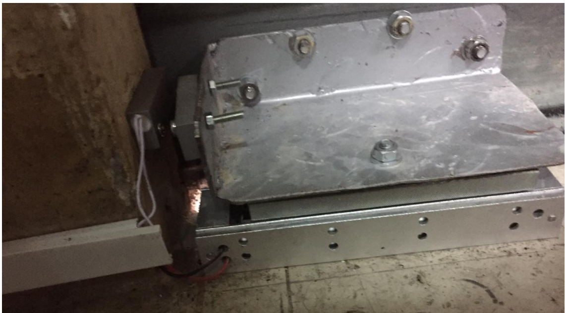
Fig.4.1.1.1. Cerradura electromagnética y contacto magnético
