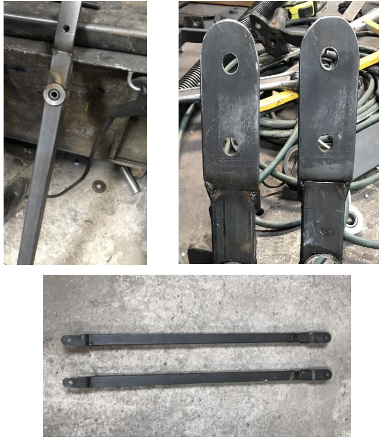
Figura 73: Proceso de soldadura bases
