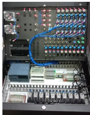
Figura 23- Cableado sección de salidas digitales
