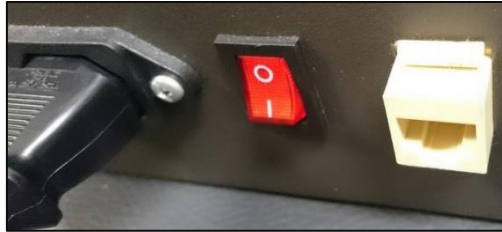
Figura 22- Alimentación, interruptor, terminal de comunicación.
