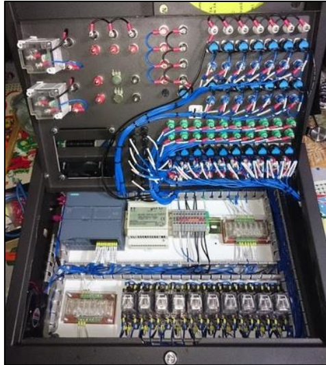
Figura 26- Vista interior del módulo de automatización
