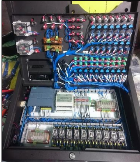
Figura 25 - Resultado final del cableado
