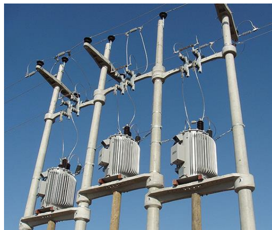
Figura 2 - Regulador de voltaje de media tensión
