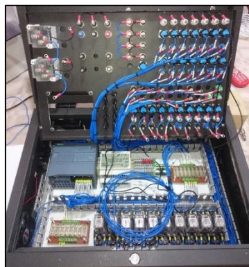
Figura 24 - Cableado de la tapa superior del módulo de prácticas
