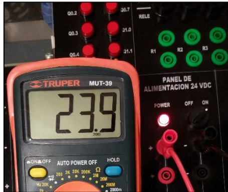
Figura 30- Medición del panel de alimentación VDC
