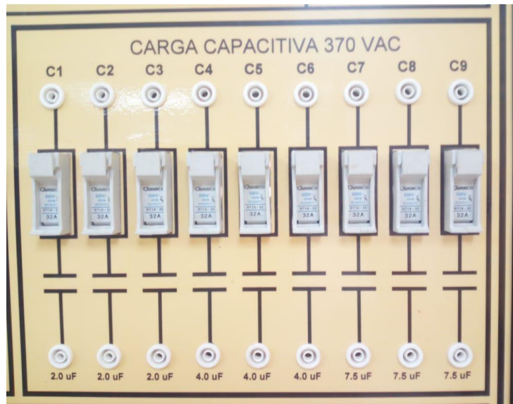
FIGURA 3. 19: MÓDULO DE CARGA CAPACITIVA 370 VAC.
