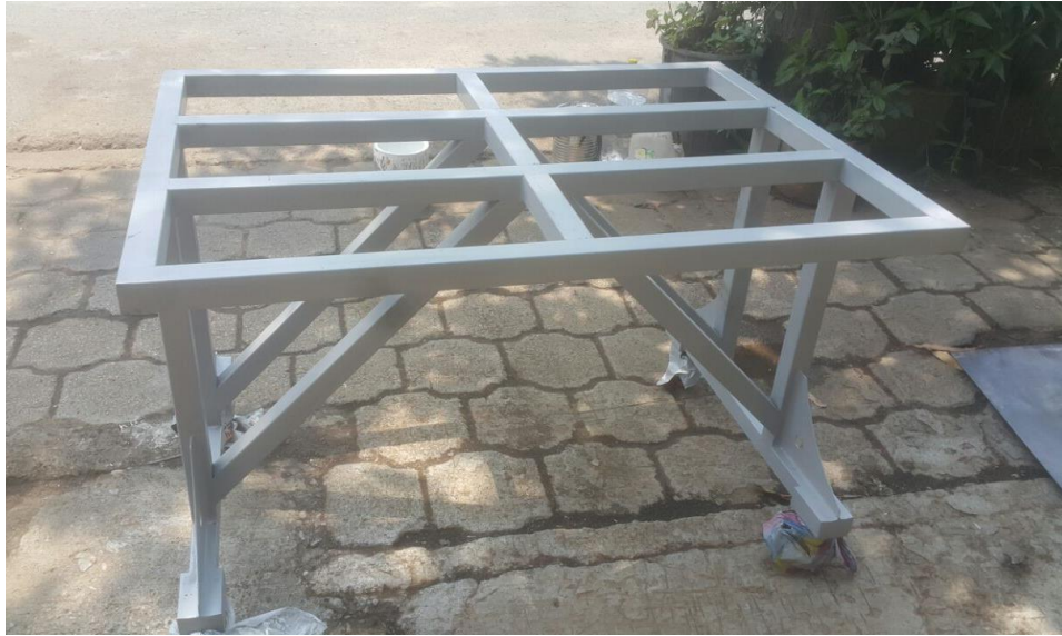
FIGURA 3. 5: CONSTRUCCIÓN DE MESA DE SOPORTE PARA MÓDULO DE PRUEBAS DE CIRCUITOS ELÉCTRICOS
