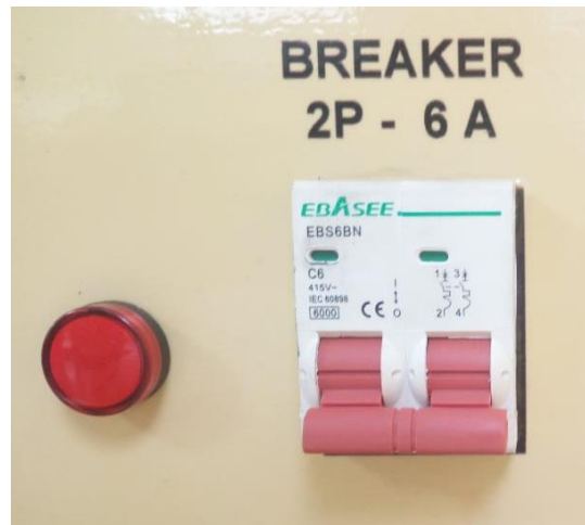
FIGURA 3. 12: DISYUNTOR BIFÁSICO 2P-6A.
