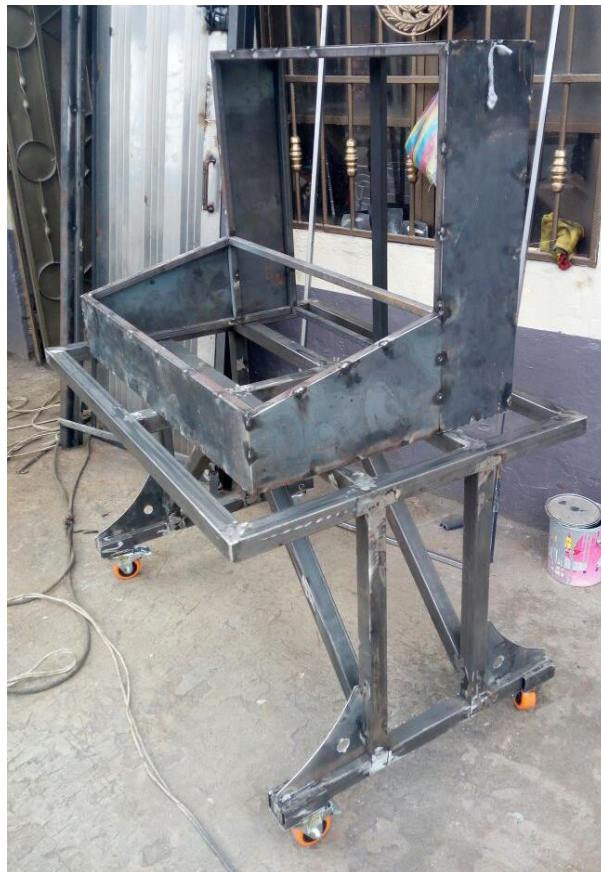
FIGURA 3. 4: CONSTRUCCIÓN DE ESTRUCTURA METÁLICA PARA MÓDULO DE PRUEBAS DE CIRCUITOS ELÉCTRICOS.
