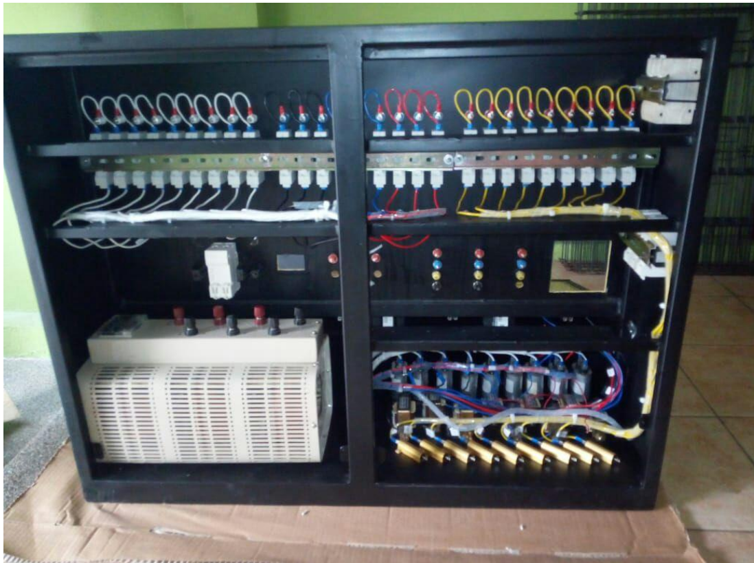
FIGURA 3. 10: CONEXIONADO Y CABLEADO DE EQUIPOS Y MATERIALES EN MÓDULO DE PRUEBAS DE CIRCUITOS ELÉCTRICOS – VISTA POSTERIOR.
