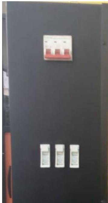
FIGURA 3. 11: DISYUNTOR TRIFÁSICO 3P-20A.
