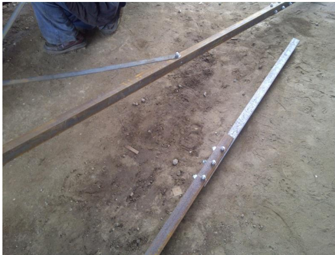
Figura 4.4 Traslape y sujeción de ángulos.
