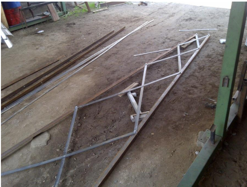
Figura 4.6 Ensamble de una cara de la torre.
