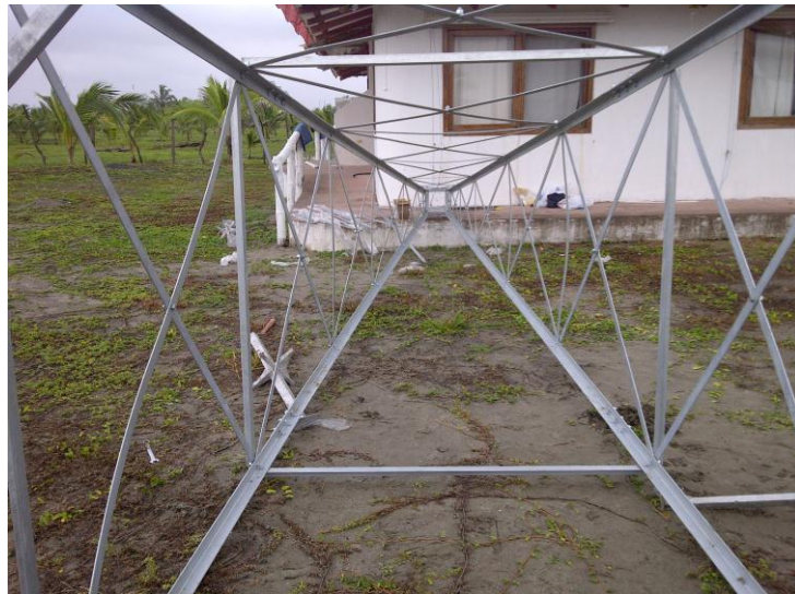
Figura 4.35 Armado de la torre en el hotel.
