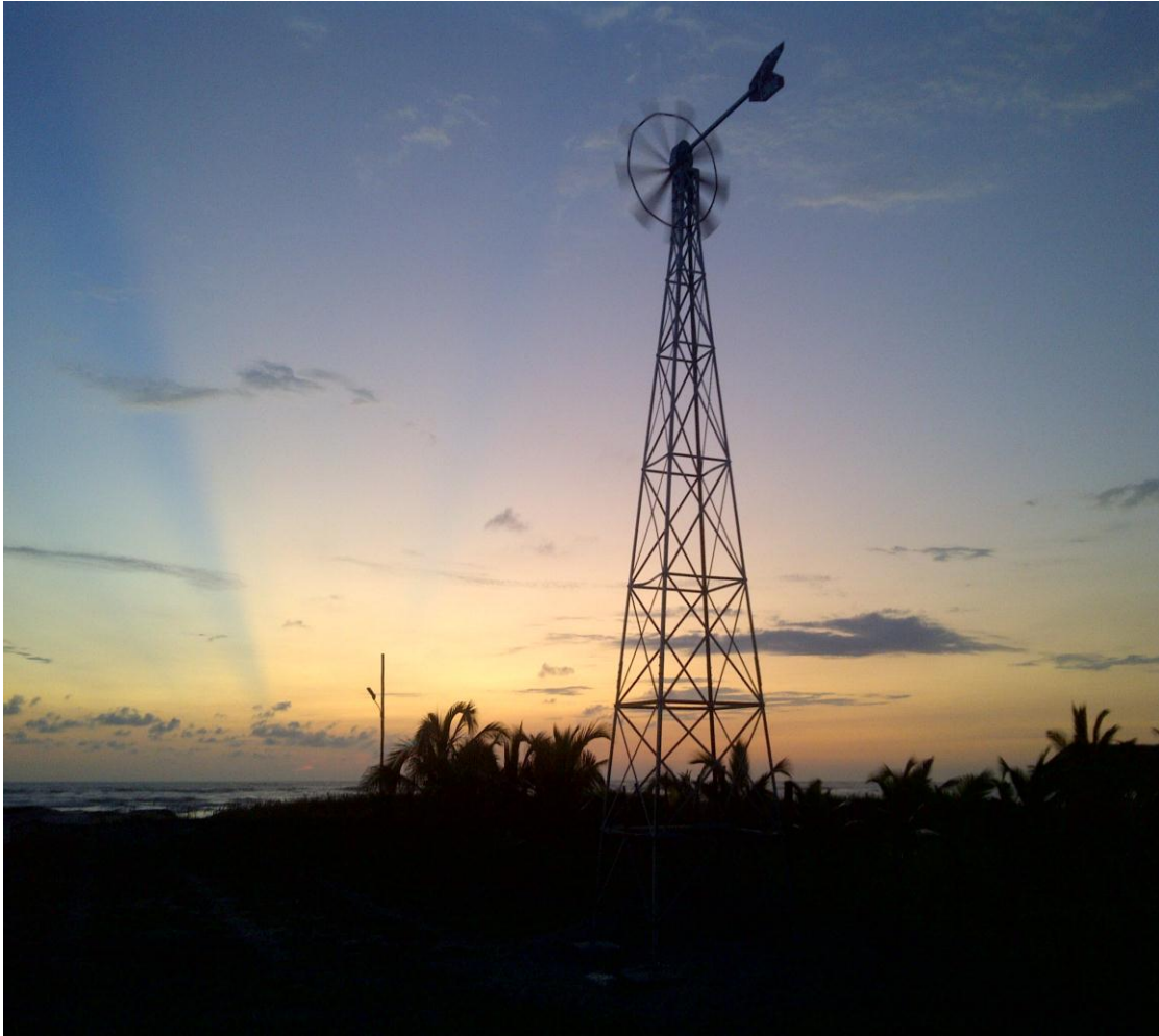
Figura 4.38 Instalación de todo el sistema en la torre.
