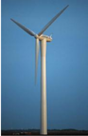
Figura 2.3.- Aerogenerador de tres palas.
