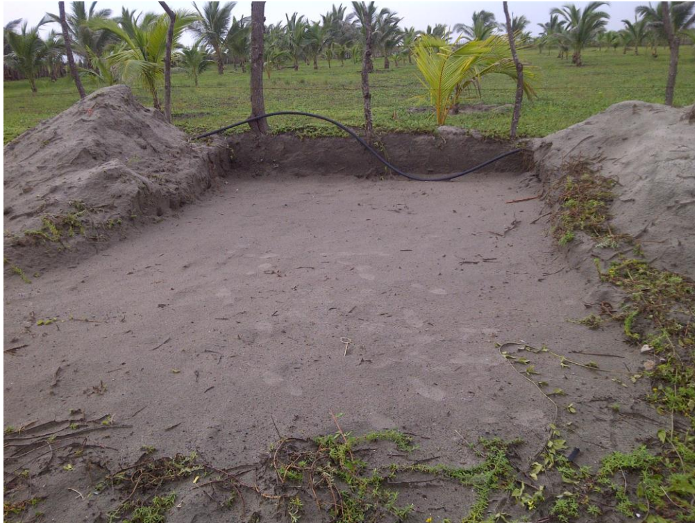
Figura 4.36 Nivelación del terreno.
