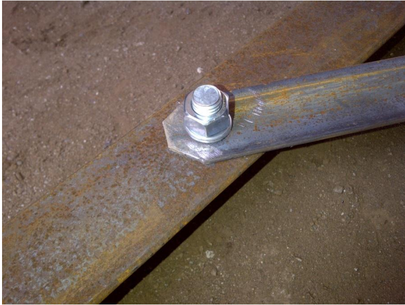
Figura 4.5 Sujeción de ángulo con platina mediante pernos.
