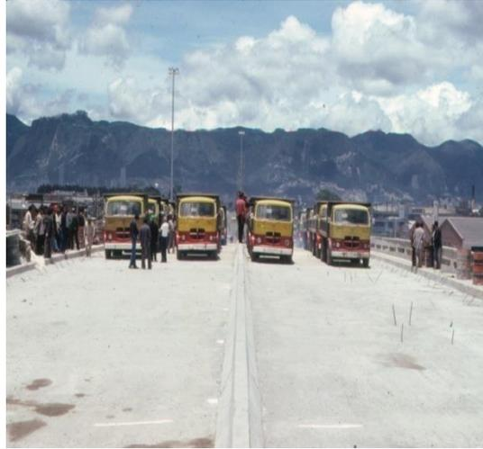
**Fig.1.50** Ensayo de carga de puente, situación de máxima carga viva.
