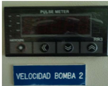
Figura 2.18 Tacómetro Fuente: Autores
