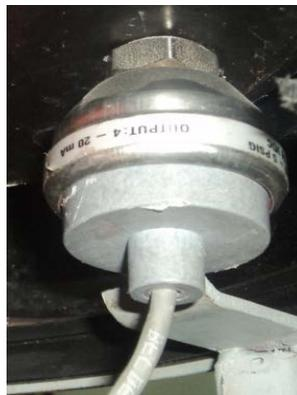
Figura 2.7 Transmisor de Presión Fuente: Autores
