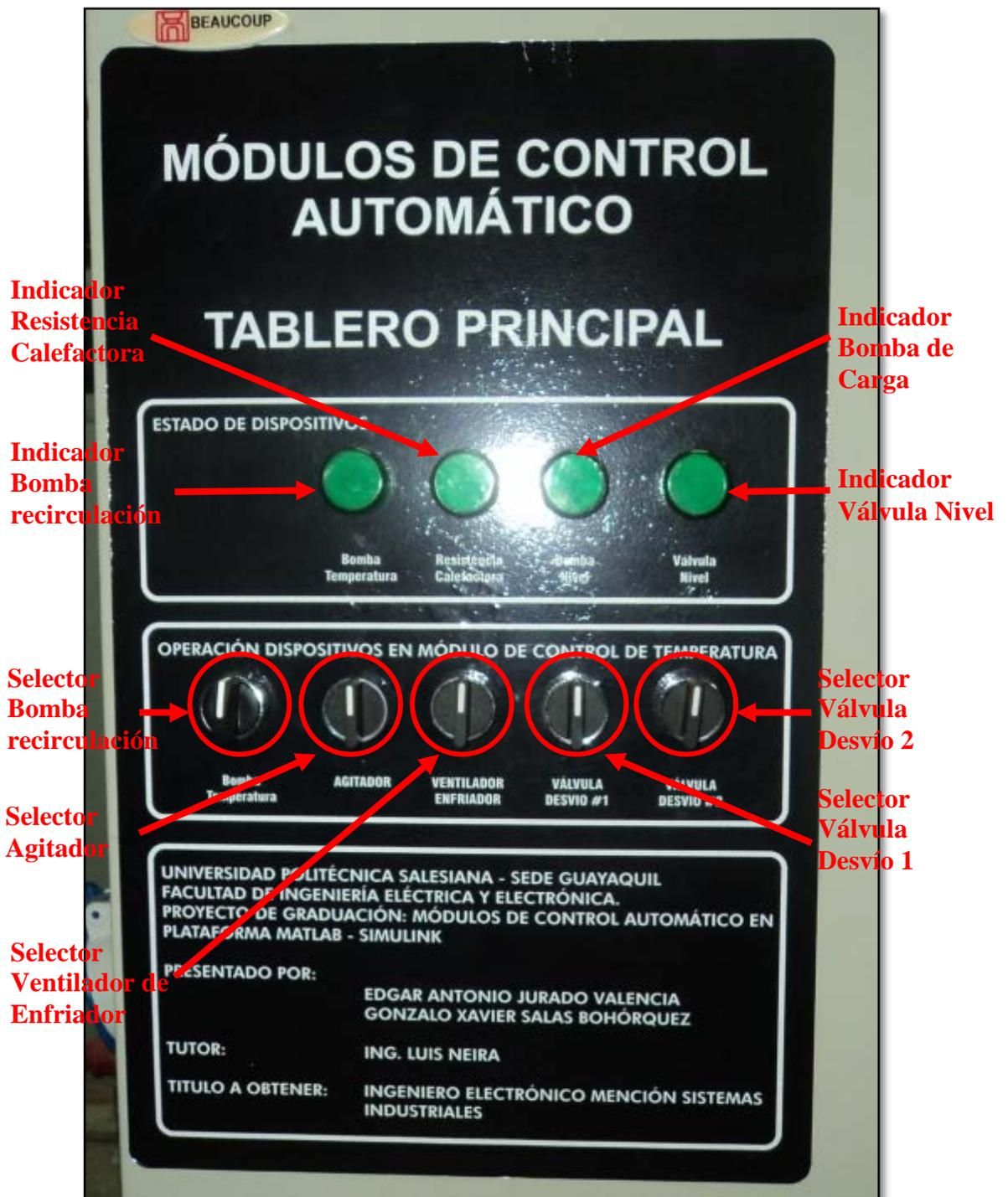
Figura 5.11 Vista de tablero principal-encendido de accesorios Fuente: Autores
