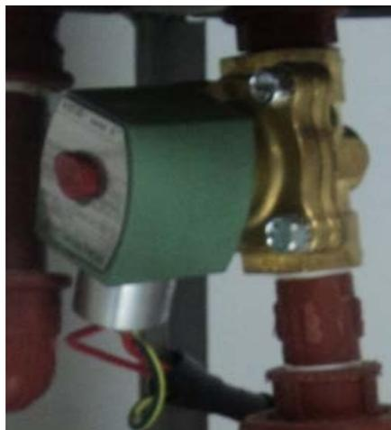
Figura 2.6 Válvula solenoide Fuente: Autores
