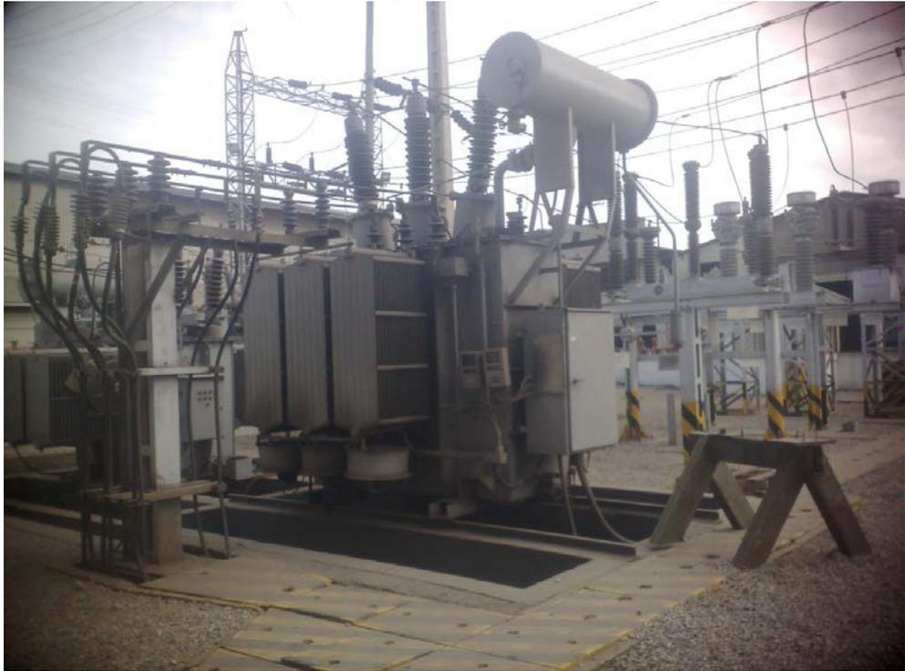
Figura 54. Ubicación real del transformador de 15MVA
