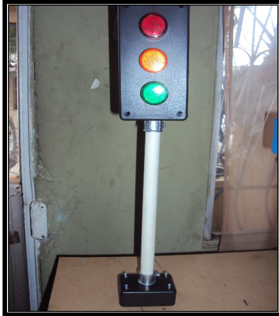
Figura 4.9 Montaje en la base luces piloto
