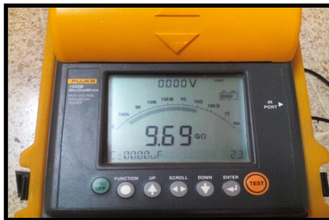
FIGURA 49: DATO DE CAPACITANCIA DEL INTERRUPTOR DE MEDIA TENSIÓN (CONTACTO- TANQUE / SWITCH CERRADO)
