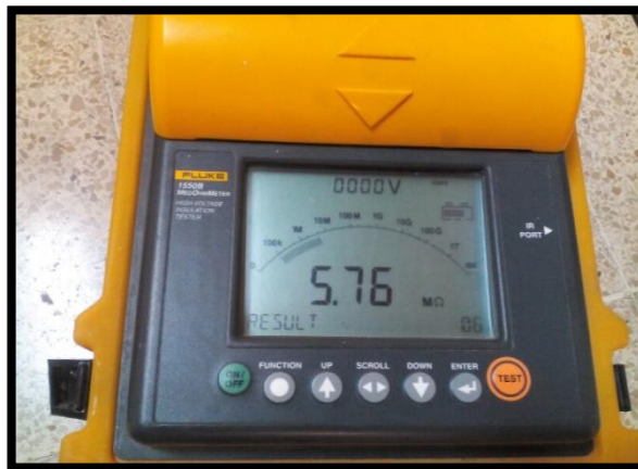
FIGURA 40: DATO DE RESISTENCIA DE AISLAMIENTO DEL INTERRUPTOR DE MEDIA TENSIÓN (CONTACTO-TANQUE / SWITCH ABIERTO)
