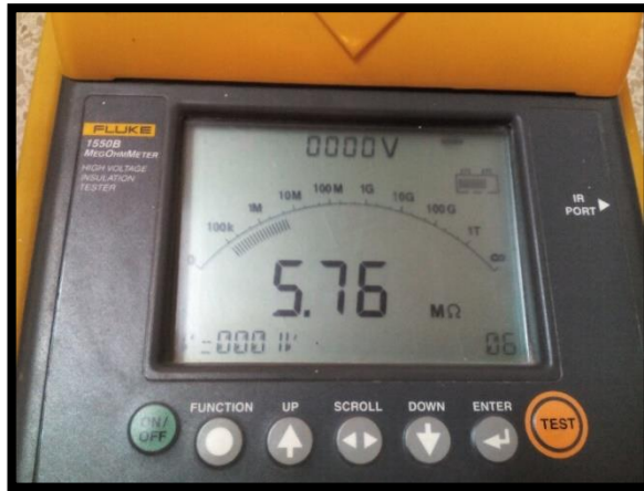
FIGURA 42: DATO DE VOLTAJE INYECTADO AL INTERRUPTOR DE MEDIA TENSIÓN (CONTACTO- TANQUE / SWITCH ABIERTO)
