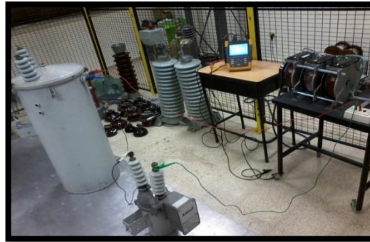
FIGURA 72: MONTAJE DEL CIRCUITO CON TRANSFORMADOR A VACÍO CON INTERRUPTOR DE POTENCIA
