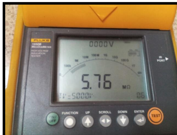
FIGURA 41: DATO DE VOLTAJE DE PRUEBA NOMINAL DEL INTERRUPTOR DE MEDIA TENSIÓN (CONTACTO- TANQUE / SWITCH ABIERTO)
