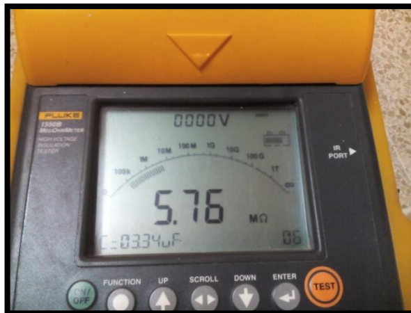
FIGURA 43: DATO DE CAPACITANCIA DEL INTERRUPTOR DE MEDIA TENSIÓN (CONTACTO- TANQUE / SWITCH ABIERTO)
