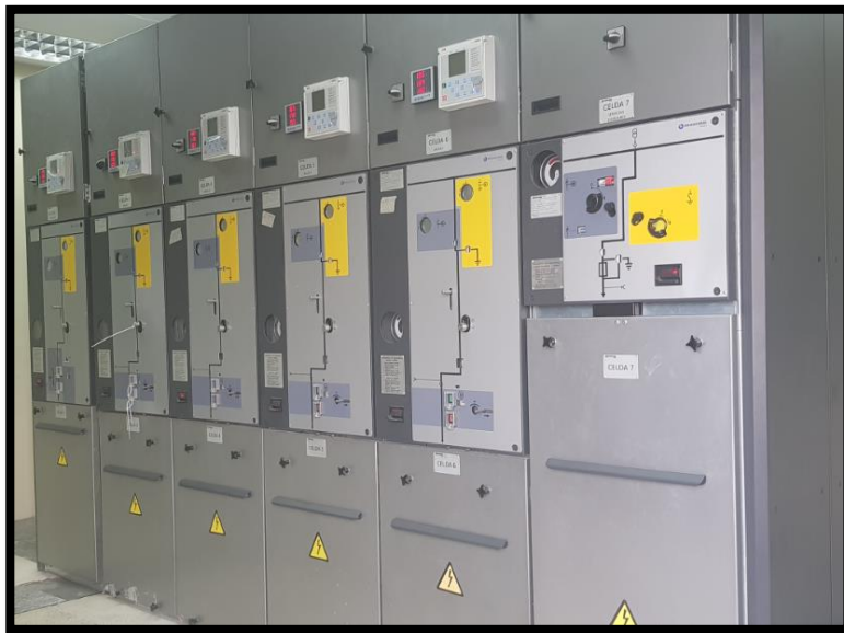
FIGURA 14 CELDA METALCLAD
