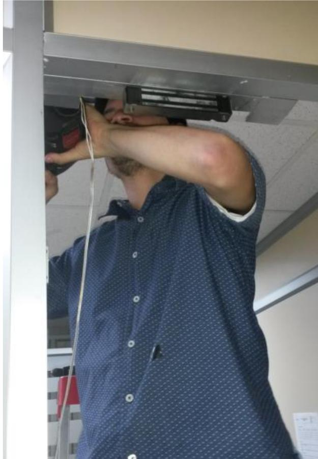
**Figura 85. Instalación de Chapa electromagnética(Los autores)**
