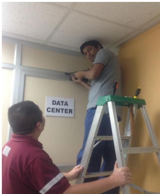
**Figura 84. Instalación del brazo mecánico en puerta de ingreso(Los autores)**
