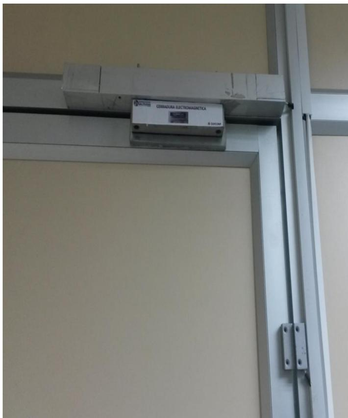
**Figura 87. Chapa electromagnética instalada(Los autores)**
