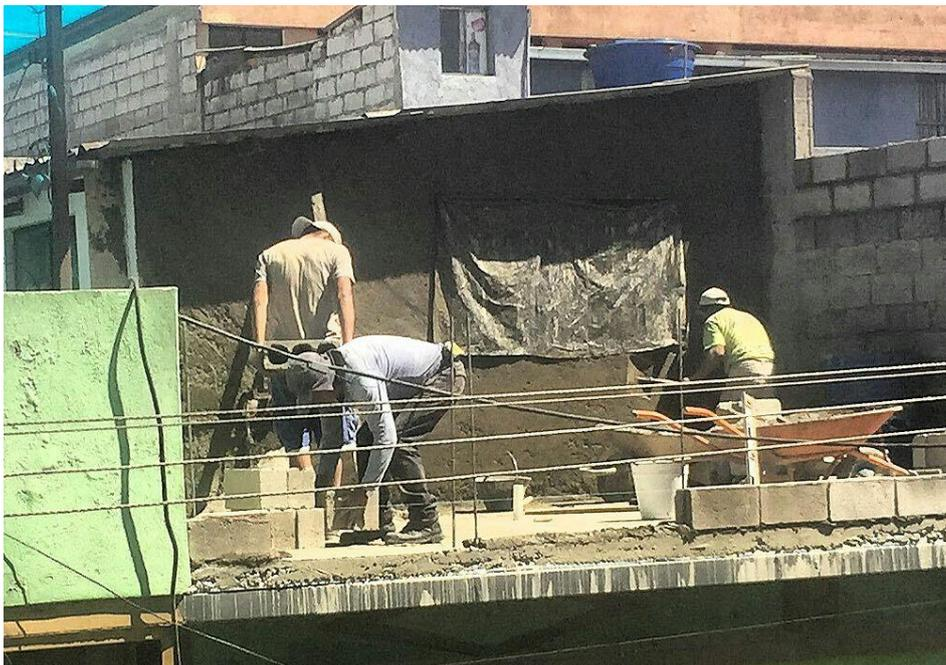
*Ilustración 4: albañiles trabajando sin protección.*
