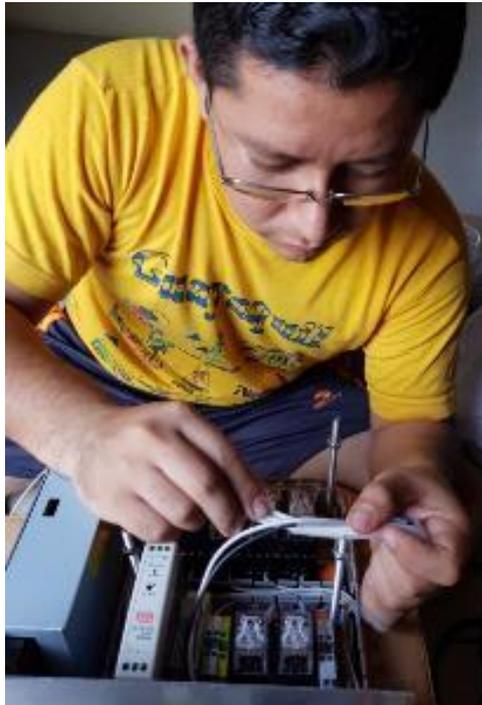
*Figura 119: Armado y conexión de tablero de control (Autores, 2018)*
