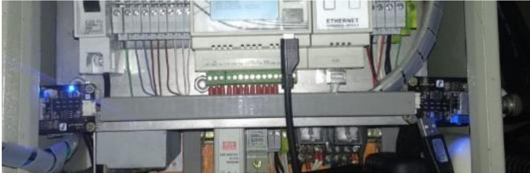
*Figura 117: Transductores de sensores de pH ubicación lateral (Autores, 2018)*
