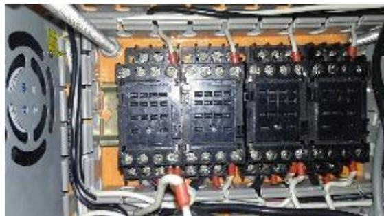
*Figura 113: Conexión de relés (Autores, 2018)*
