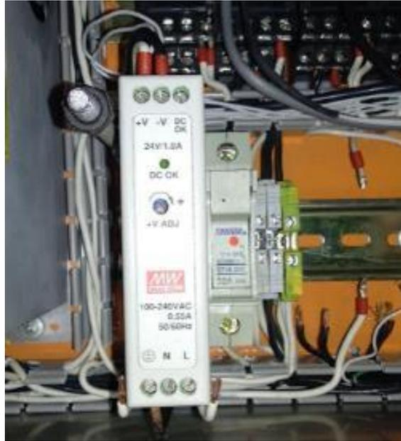
Figura 114: Conexión de fuente, fusilera y borneras (Autores, 2018)
