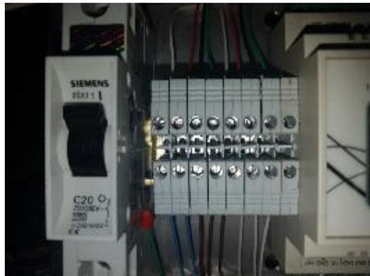
*Figura 112: Instalación de borneros, breaker y cables de control (Autores, 2018)*
