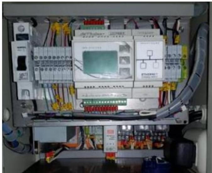
*Figura 118: Conexiones marquilladas (Autores, 2018)*
