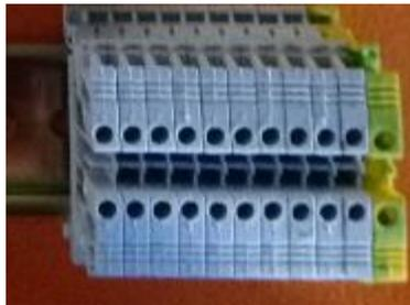
*Figura 61: Borneras para riel din (Autores, 2018)*
