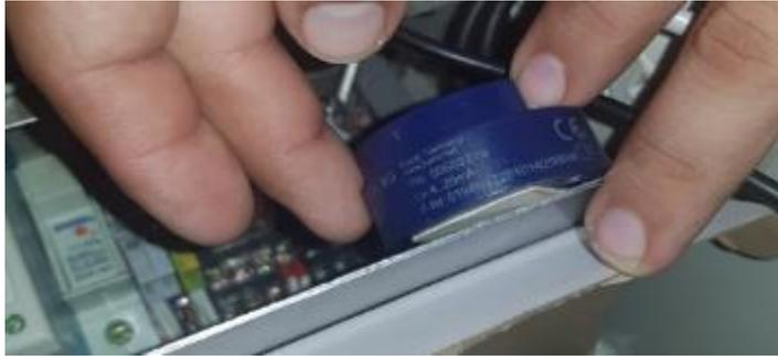
Figura 143: Instalación del transductor de PT100 (Autores, 2018)
