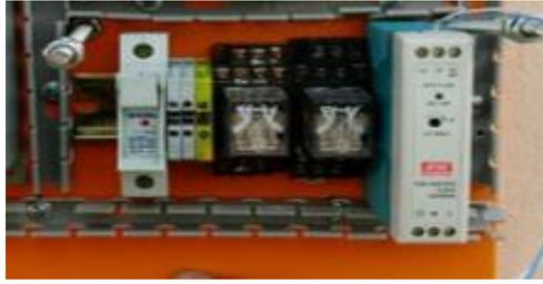
Figura 105: Fuente 24VDC, fusilera, borneras de fuerza (Autores, 2018)
