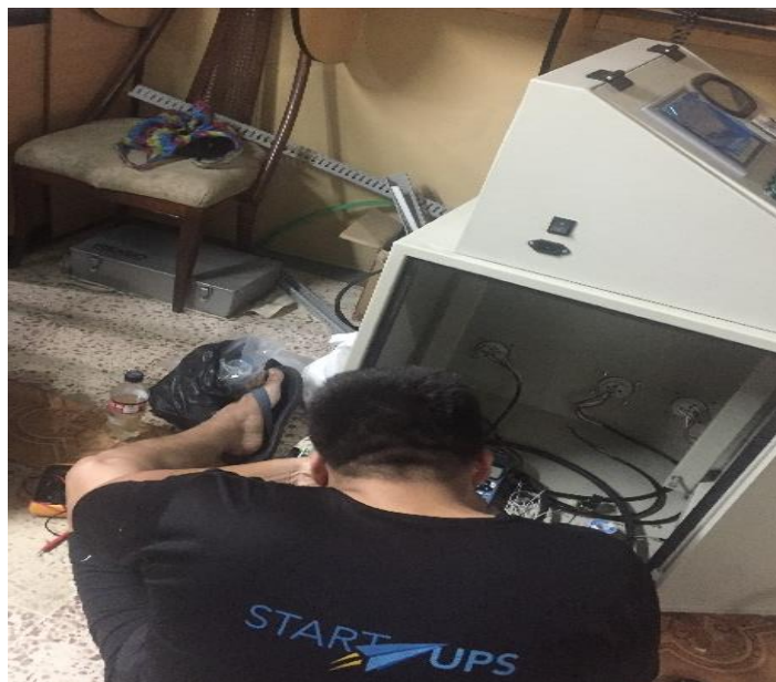
Figura 122. Proceso de cableado para tablero de etiquetadora. (Los Autores).
