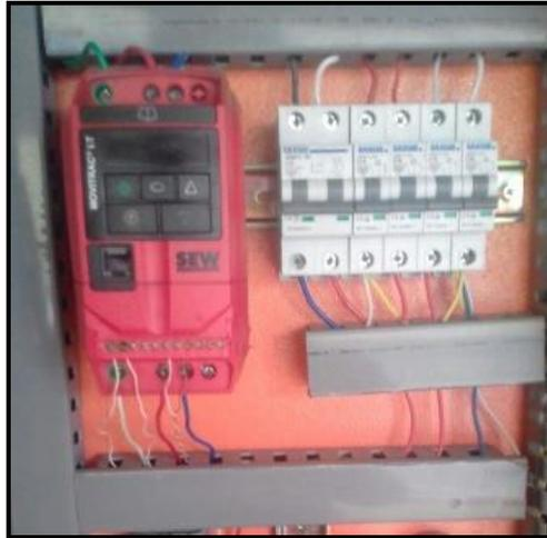
**Figura 67.** Montaje del variador en el tablero.
