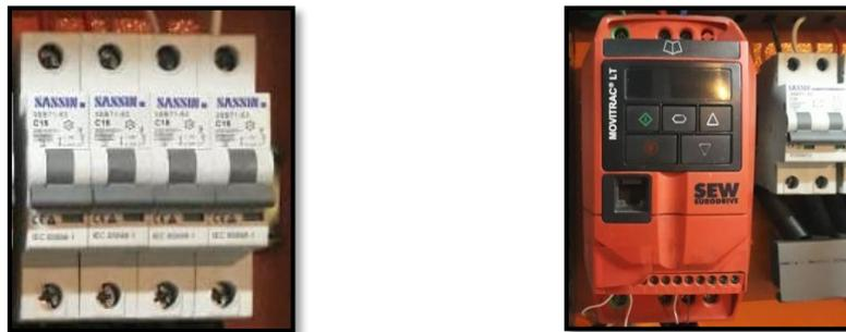
**Figura 48.** Breakers de protección y Variador de frecuencia SEW.
