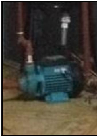
**Figura 56.** Bomba monofásica de 220 Vac.
