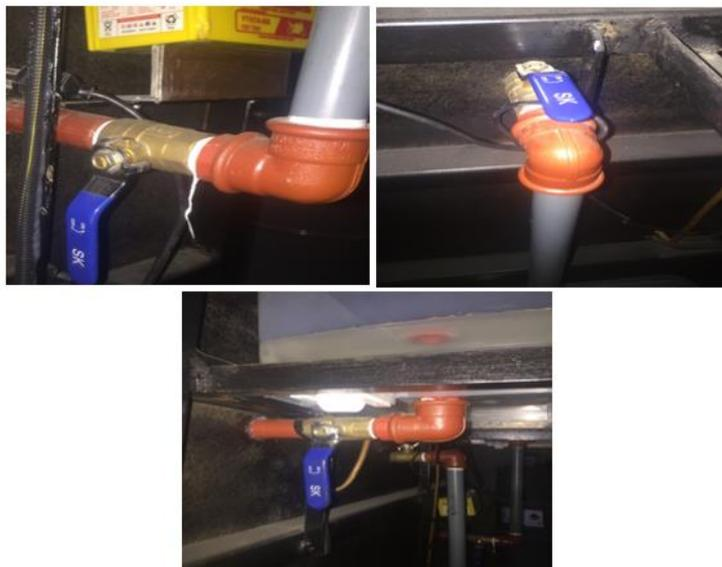
**Figura 45:** Llaves de paso, alimentación y desfogue de Tanques.
