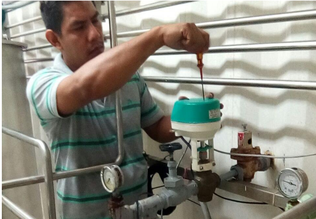
Figura 48. Instalación de válvula eléctrica de posicionamiento Elaborado por: Autor
