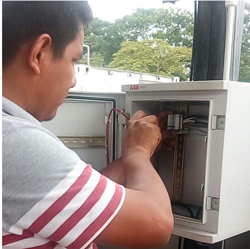
Figura 50. Instalación tablero de control en campo Elaborado por: Autor
