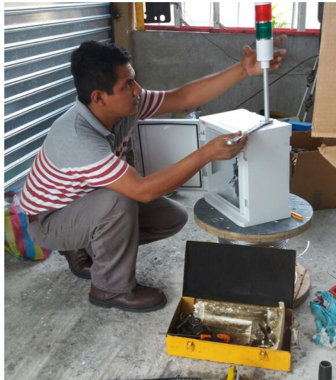
Figura 45. Ensamblaje de elementos en tablero de control Elaborado por: Autor
