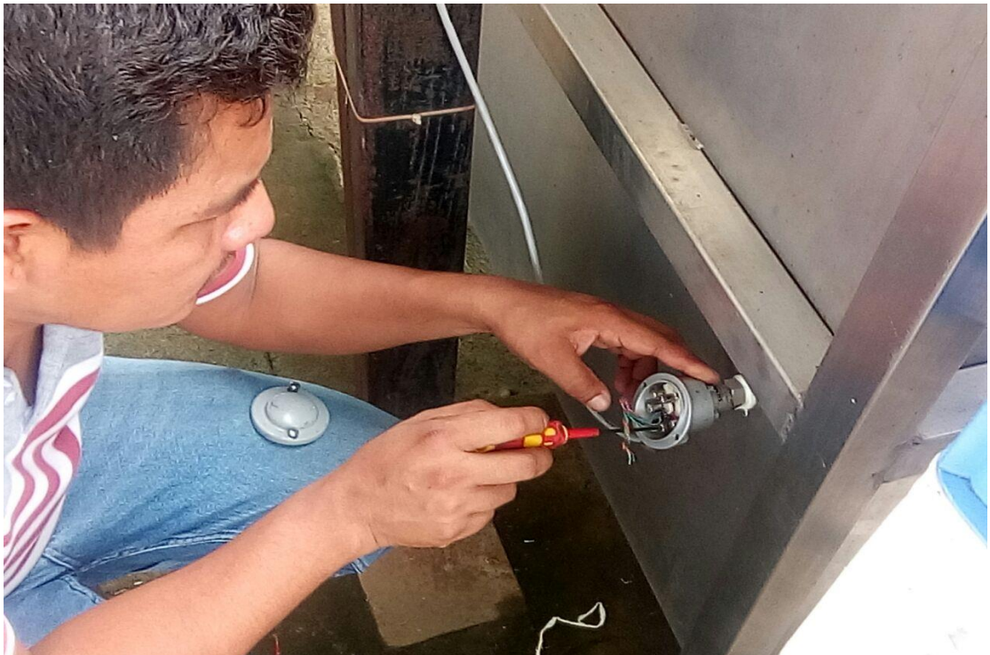
Figura 49. Instalar sensor PT 100 en tina de calentamiento Elaborado por: Autor
