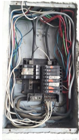
Colocación de Breaker para alimentación de dispositivos.
