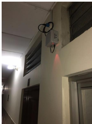
Instalación de repetidores en el pasillo de las habitaciones.
