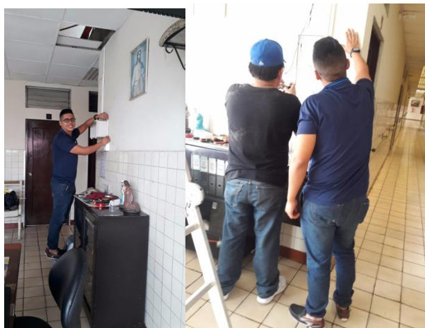
Colocación del monitor de control.
