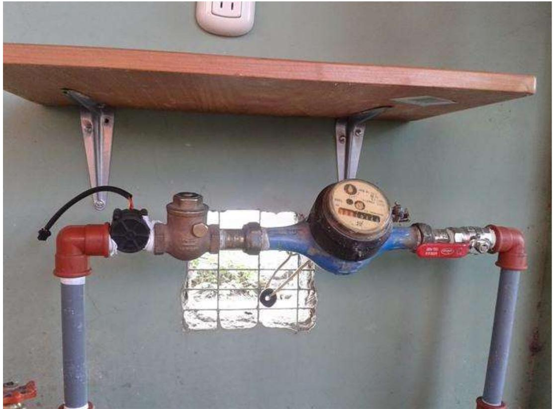
Figura 1.4 Sistema de medición de consumo de agua basado en un sensor Hall
