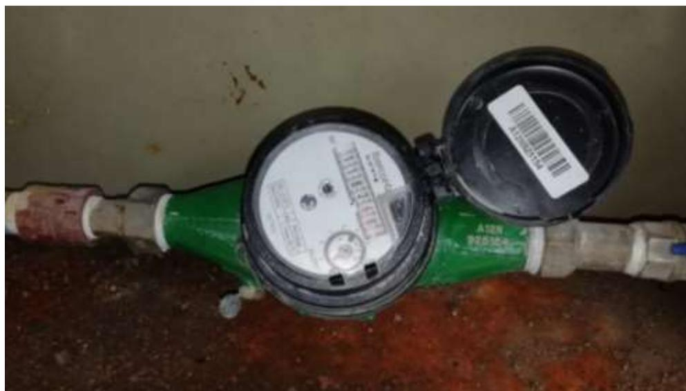
Figura 1.7 *Medidor de chorro múltiple*
