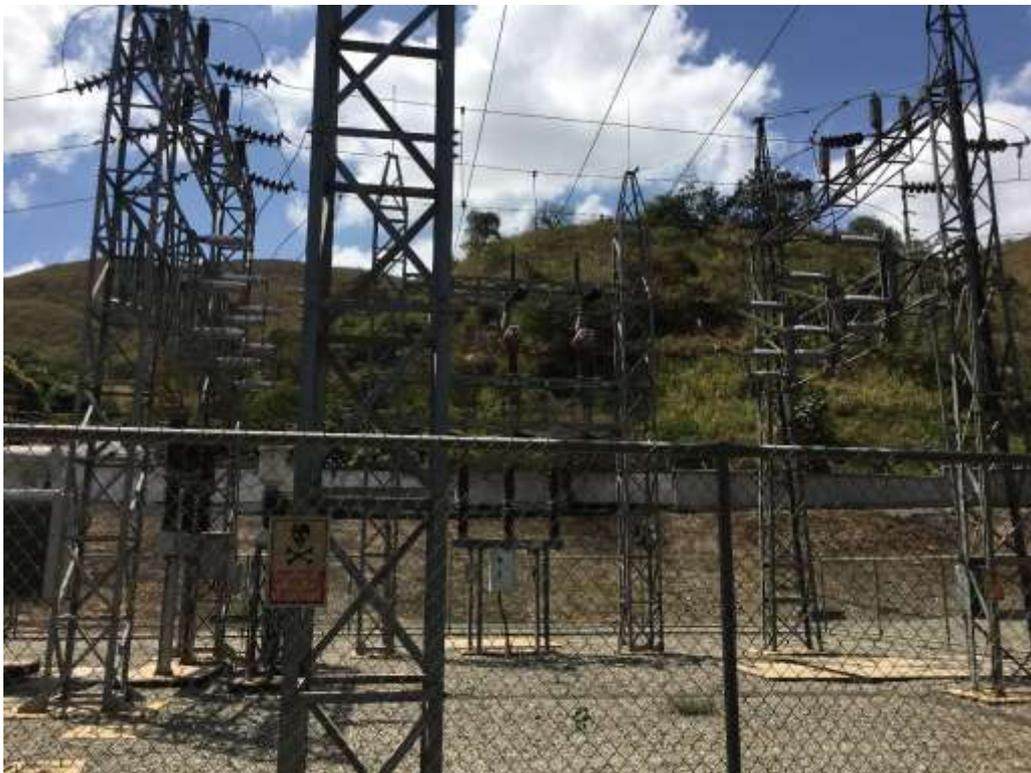
**Figura 3-4.** Vista de la Subestación “Portovelo”, estructuras de subtransmisión a 69 kV.
