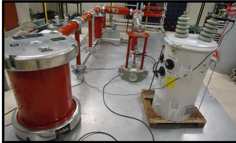
FIGURA 47: TRANSFORMADOR SOMETIDO A PRUEBA DE IMPULSO TIPO RAYO.
