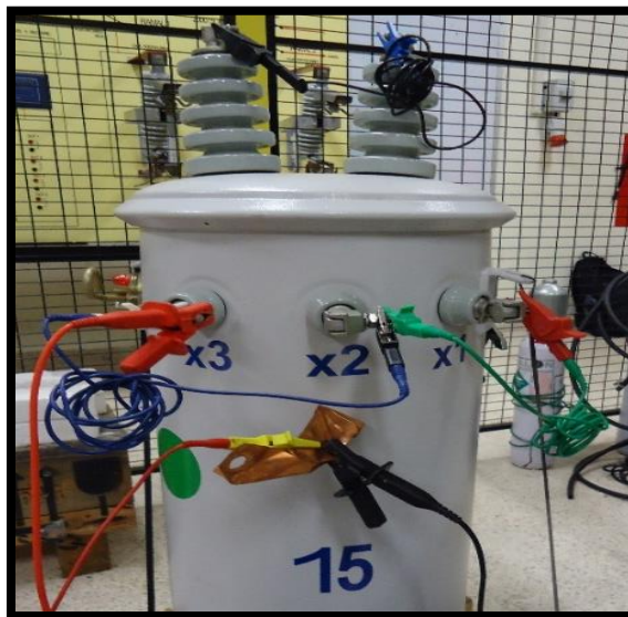
FIGURA 54: TERMINALES DE ALTA Y BAJA TENSIÓN CORTOCIRCUITADOS.
