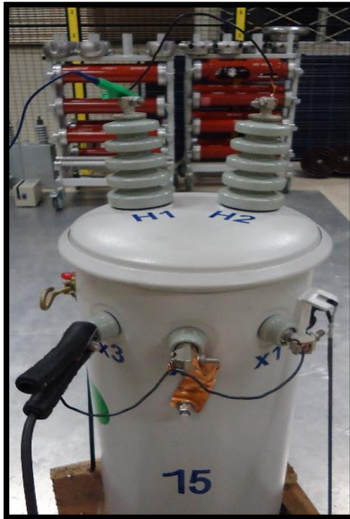
FIGURA 61: TERMINALES DE ALTA Y BAJA TENSIÓN CORTOCIRCUITADOS PARA PRUEBA DE VOLTAJE APLICADO.
