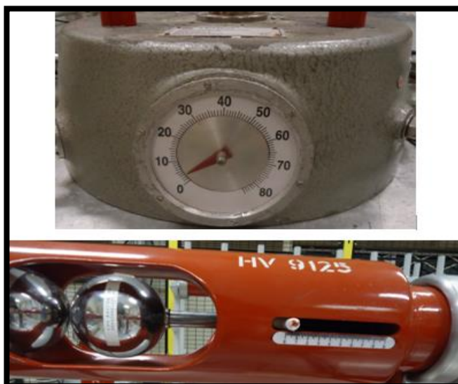
FIGURA 46: CALIBRACION DEL ESPINTEROMETRO DE MEDICIÓN HV9133 Y DEL ESPINTERÓMETRO DE ESFERAS HV9125 PARA PRUEBA DE IMPULSO TIPO RAYO.
