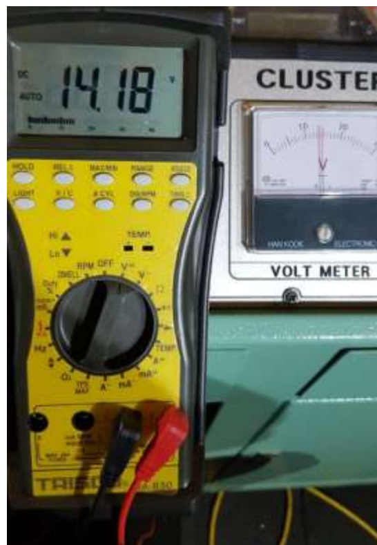
Figura A - 24. Voltaje de batería a un régimen de ralentí. Fuente: Autores.
