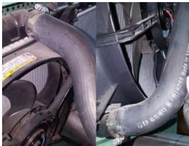
Figura A - 18. Comprobación de fugas en el sistema de refrigeración. Fuente: Autores.
