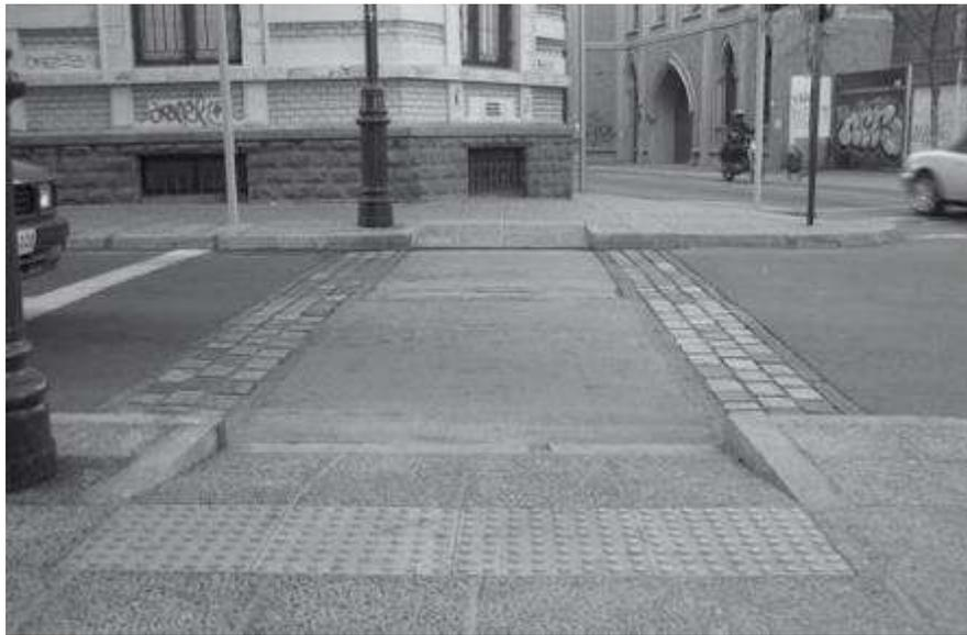
*Figura 1: Rebaje con buen uso de contextura y diferenciación de pavimentos.
