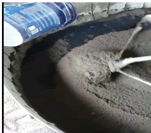
Figura 4. Colocación del caucho en la mezcla de hormigón
