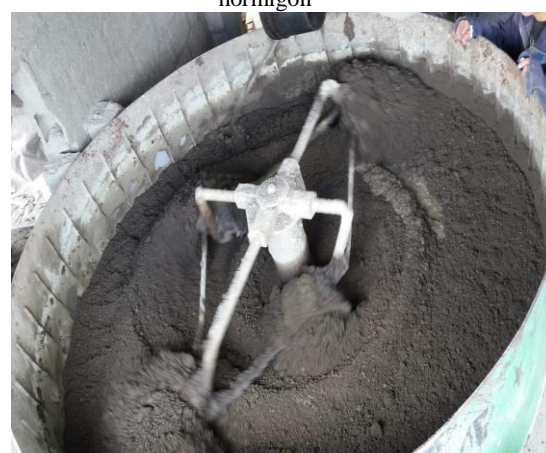
Figura 5. Mezcla completa del caucho en el hormigón
